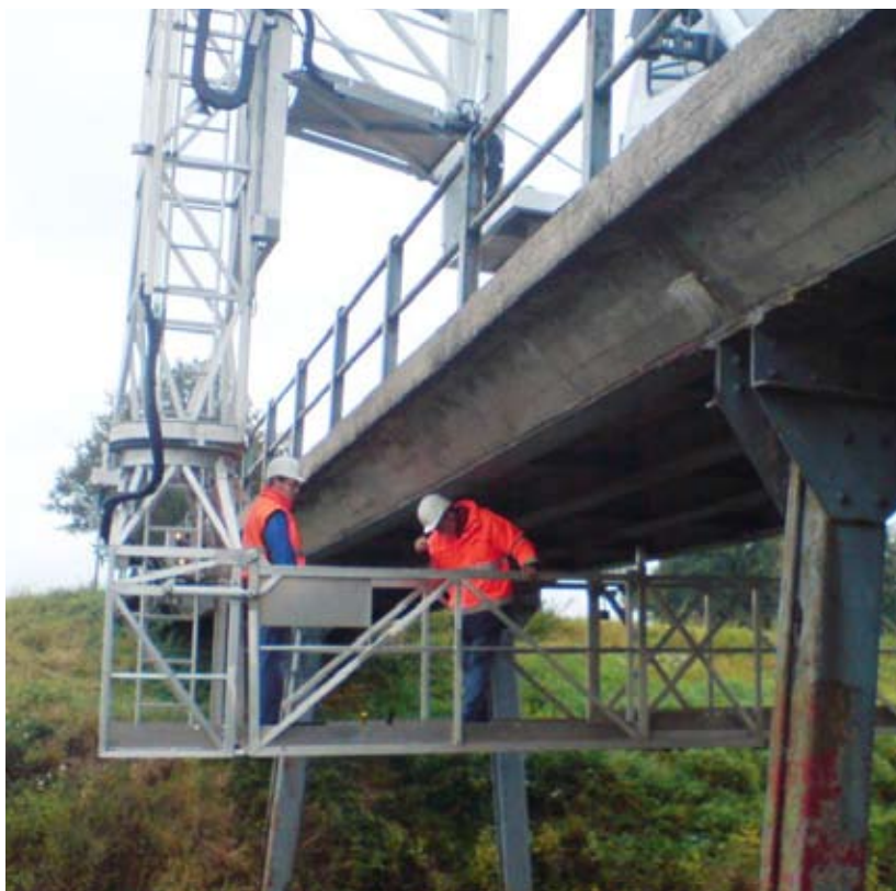
Ingenieure untersuchen den Unterbau der Brücke über die Ems.
