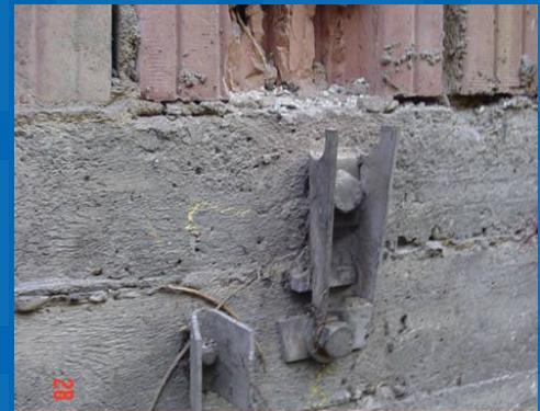
Aufhängekonstruktion der demontierten Betonfassade
