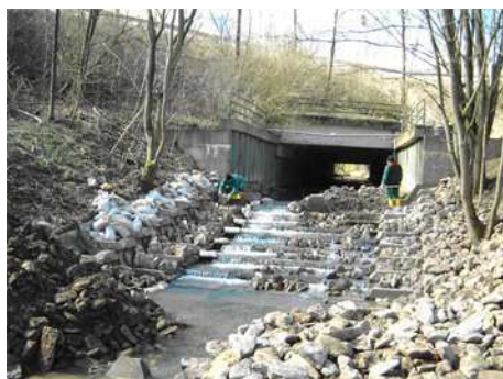
Ehemaliger Pfeiffenbrinkscher Sohlabsturz bei der Umgestaltung in eine raue Gleite; ein für Fische und Kleinlebewesen unüberwindliches Hindernis.
