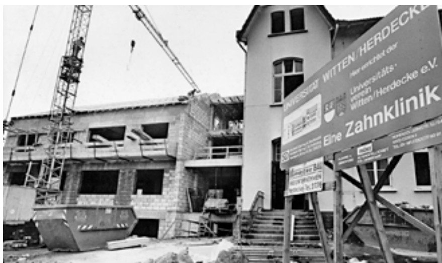
Zahnklinik in Witten-Bommern während des Erweiterungsbaus
