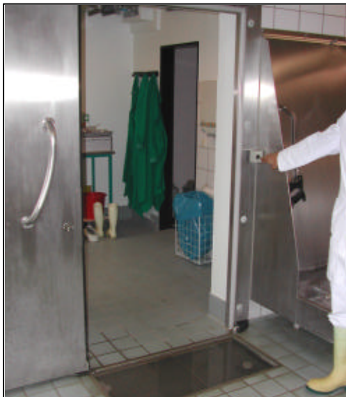
(a) Tür zum Sektionsraum, Lichtschrankensteuerung
