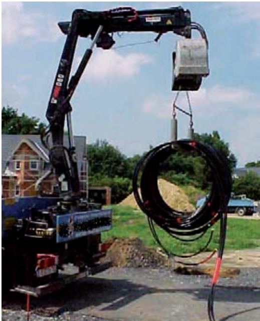
[Bild 13] Sondenrohr vor dem Einbau
