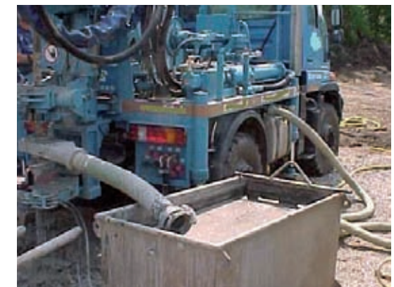
[Bild 28] Bohrfahrzeug mit Auffangbehälter
