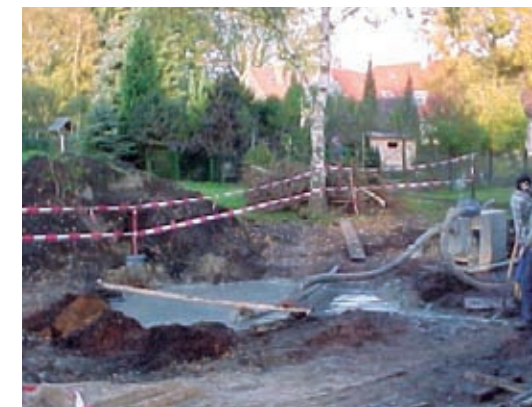
[Bild 27] Bohrschlammeinleitung in Mulde
