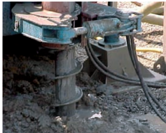
[Bild 25] Bohrfahrzeug während einer Bohrung
