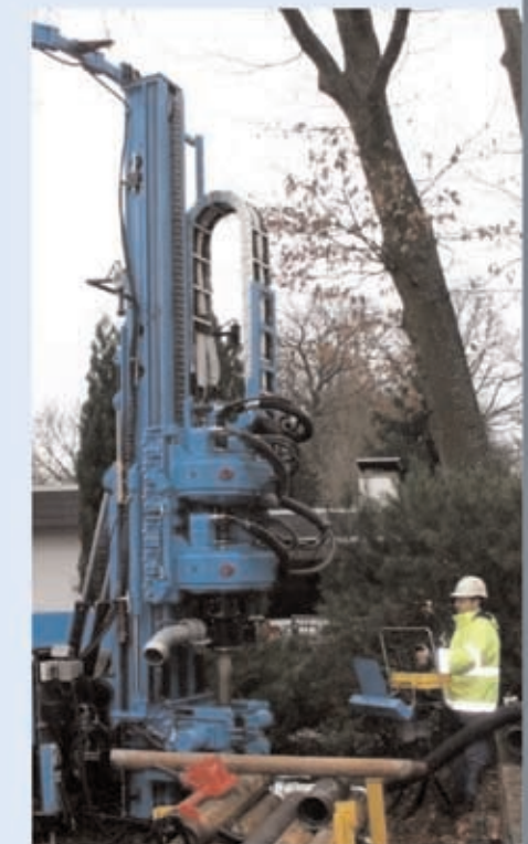
Erdwärmesondenbohrung Einfamilienhaus
