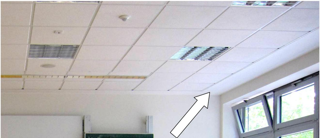
*Abb. 24: Neuere Akustikdecke, nicht flächendeckend bis zum Raumrand verbaut. Dadurch fehlt i.d.R. die tieffrequente Wirkung, die insbesondere im Raumrandbereich erzielt werden kann.*
