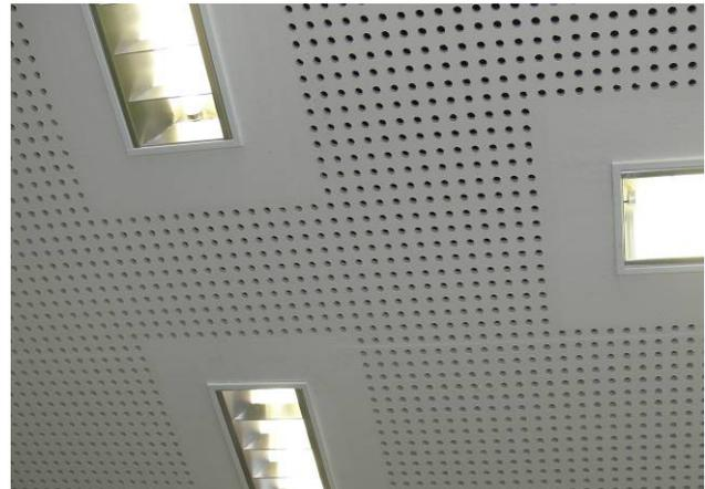
Abb. 19: Akustikdecke mit integrierter Beleuchtung
