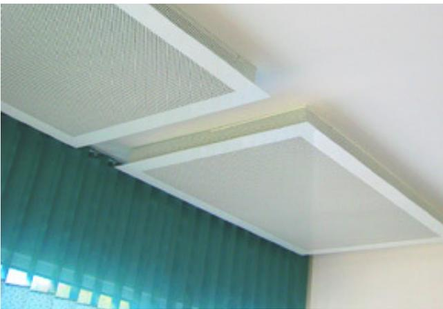
Abb. 32: Resonatoren als Deckenelemente,
