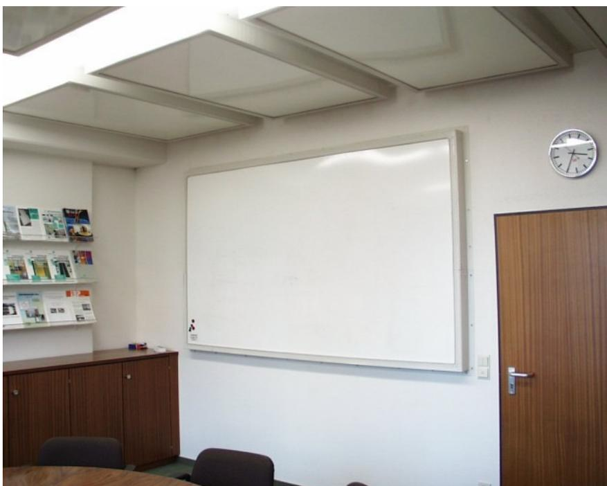
Abb. 36: Plattenresonatoren im Wand- und Deckenbereich eines Konferenzraums
