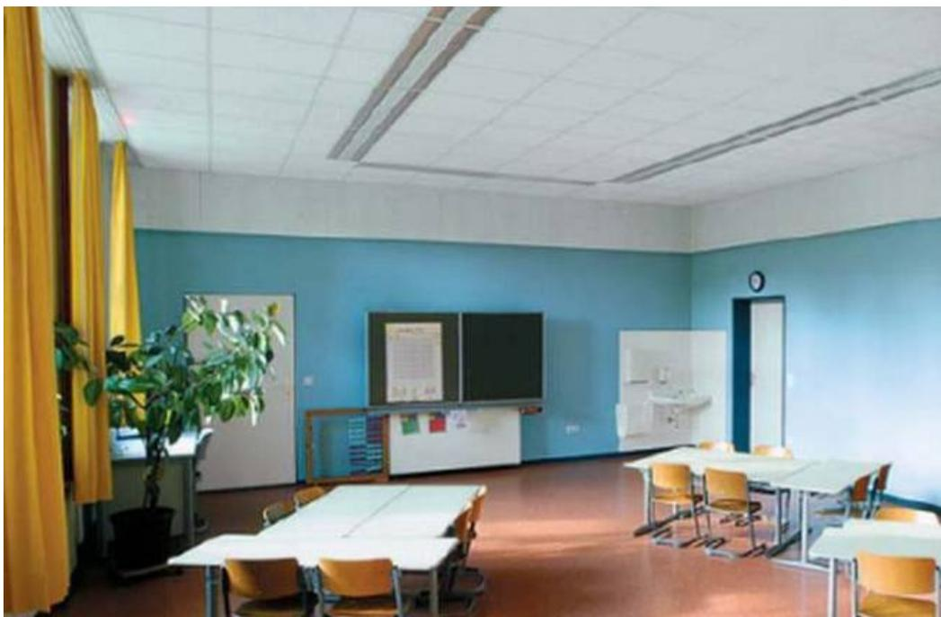
Abb. 35: Neu gestaltetes Klassenzimmer mit Rockfon-Akustikdecke einschließlich Wandfriesen, die insbesondere im tieffrequenten Bereich wirksam sind. Quelle: [www.rockfon.de](http://www.rockfon.de)
