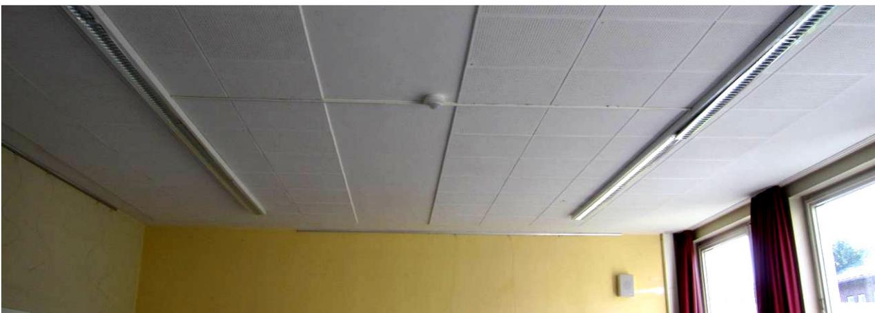
*Abb. 23: Untergeklebte dünne Akustikplatten eines Klassenraumes. Die Wirkung macht sich nur im hochfrequenten Bereich bemerkbar, im tieffrequenten Bereich gibt es so gut wie keine akustische Nachhallreduzierung.*
