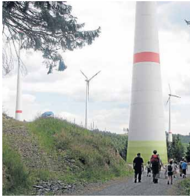
Der Bürgerwindpark in Hilchenbach steht seit 2008.
