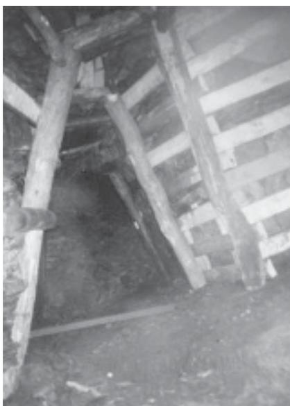
Abb. 11: Aufwältigung und Sicherung einiger Meter des ehemaligen Abbaus nach Nordosten, 1997
