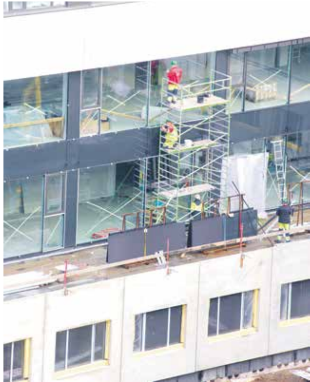
Das Gebäude ID in der Entstehungsphase. An seinem Beispiel lernen die Studierenden eine Baustelle zu planen.
