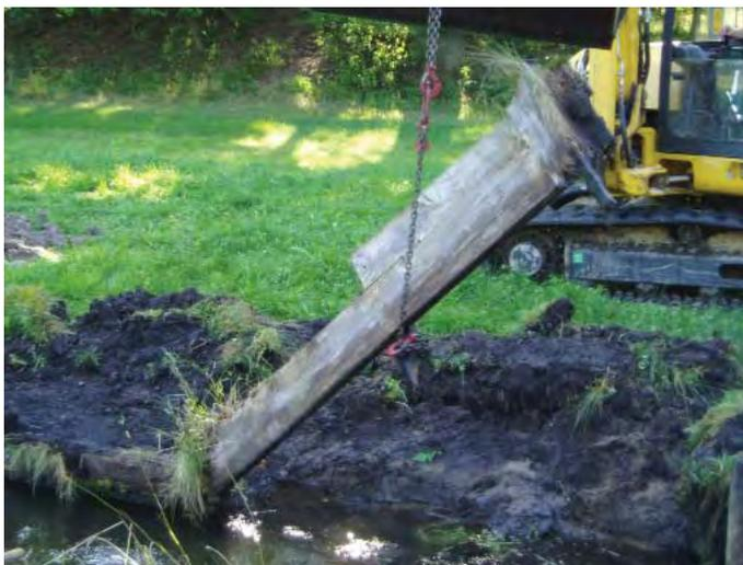
Bild 2: Entfernen der maroden Flügelwände am Pegel Staumühle Hausenbach
