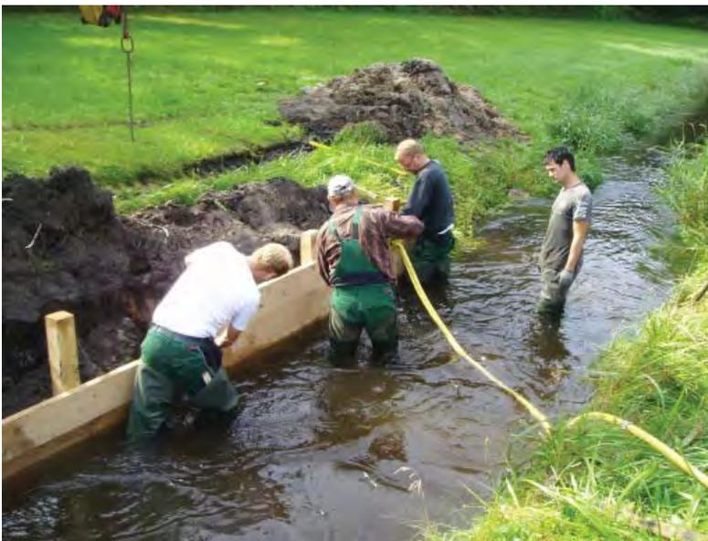
Bild 4: Mitarbeiter der Baufirma beim Setzen der Flügelwände
