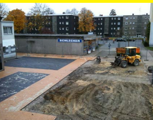
Es geht voran: Gut ein Viertel der Platzfläche ist schon neu gepflastert
