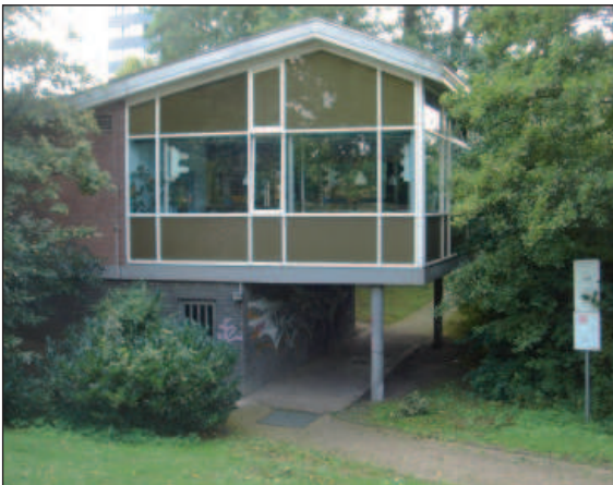
Gebäudeteil LUNA am Sennestadtteich
