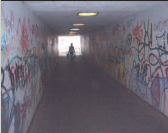
Fußgängertunnel am Zentrum
