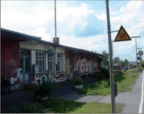
Bahnhof Senne - Krackser Bahnhof (DB) an der Bahnlinie Bielefeld - Paderborn
