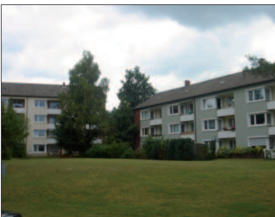
Beispiele von Gebäudetypen des Mehrfamilienhausbestandes
