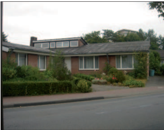
Beispiele für den unterschiedlichen Erhaltungs- und Modernisierungszustand der Ein- / Zweifamilienhäuser
