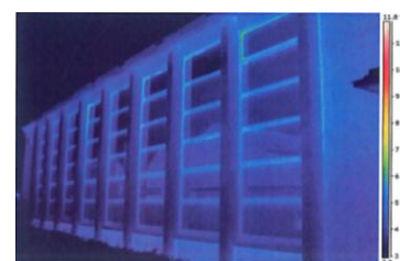
Fensterfront nach der Sanierung
