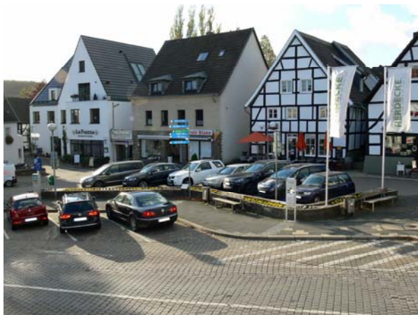
Der Platz an der Kampstraße wird umgebaut.
