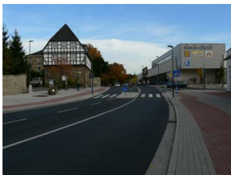
Optik der Pflasterung wird fortgesetzt.
