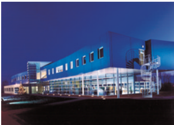
Das Firmengebäude in Leszno macht deutlich, welchen hohen Stellenwert die polnische Winkhaus-Investition einnimmt.
