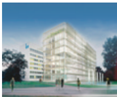
Mit dem Neubau zur Erweiterung der Hauptverwaltung setzt die Gelsenwasser AG gleich mehrere Zeichen. Unübereinstimmend ist der städtebauliche Akzent mit der gläsernen Fassade und der Transparenz. In dem Neubau wird nicht nur Raum für 200 Mitarbeiter geschaffen, sondern er bietet Platz für 50 neue Arbeitsplätze, die bis 2005 entstehen sollen. Das Unternehmen bekennt sich mit dieser Investition von circa 16 Millionen Euro zum Standort Gelsenkirchen.
