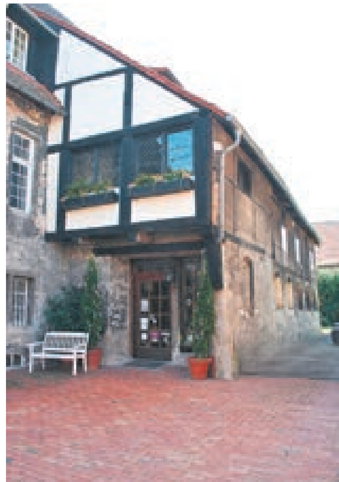
Das original erhaltene Fachwerk ist ein echter Hingucker.
