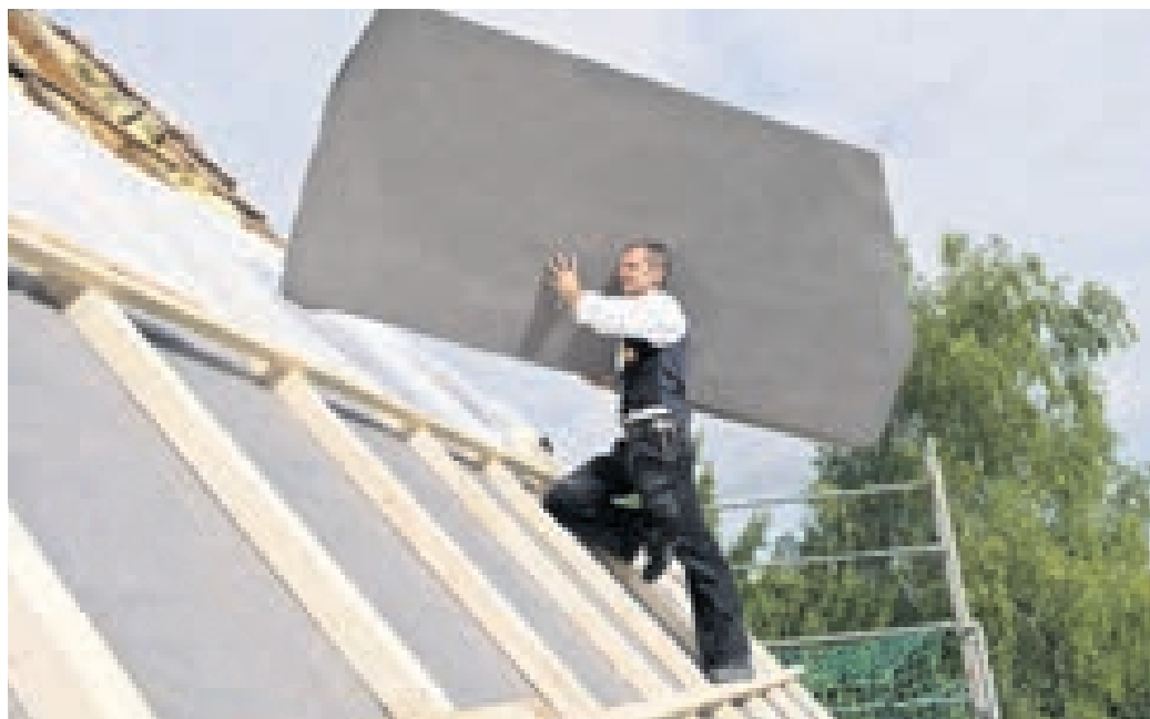
Seegras eignet sich ideal zum Dämmen von Dächern.
