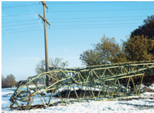
Über 80 Hochspannungsmasten knickten unter dem extremen Gewicht vereister und „schwingender“ Leitungen ein. Stunden- oder tageweise waren 250 000 Menschen im Westmünsterland ohne Strom. Das Wirtschaftsleben kam ins Stottern oder ganz zum Erliegen.
