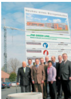
Grundstein gelegt: Nellen & Quack baut ein neues Verwaltungsgebäude. Foto: Nellen & Quack
