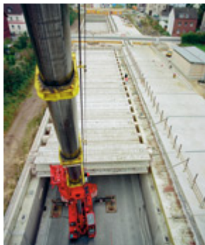
Straßenbau-Mittelstand im Einsatz: Von Schäfer gebauter Tunnel der Autobahn A 2 in Geisenkirchen. Fotos: Archiv Schäfer, Fotobaus Kiepert/Lengrich, Gisela Franke.
