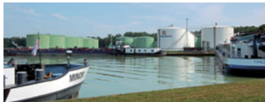
70 Millionen Liter fassen die 23 Tanks in Münster-Gelmer. Vor 40 Jahren wurde der Umschlagplatz in Betrieb genommen. Am 23. September kann er besichtigt werden. Foto: Westfalen AG
