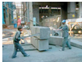
Handarbeit und viele Menschen sind auf indischen Baustellen oft preiswerter als der Einsatz von Maschinen.
