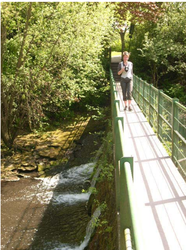
Metallsteg über das Wehr des Stauteiches II
