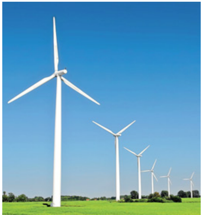
Vernetzt: Die Windenergiebranche rund um Rheine.
