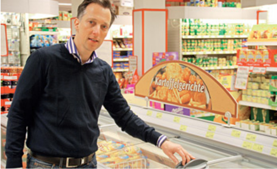
Glasschiebedeckel halten die Kälte in den Truhen. Eine einfache, aber effiziente Maßnahme zum Energiesparen im Frischmarkt Eckmann.
