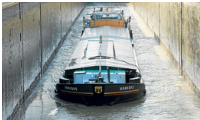
Fünf Schleusen des Dortmund-Ems-Kanals sollen erneuert werden, damit auch Großmotorgüterschiffe ihn passieren können.
