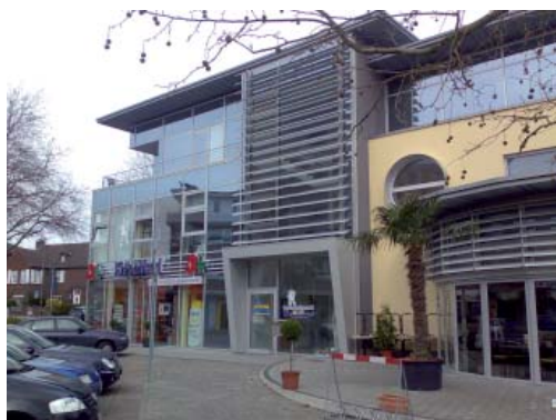
Wohn- und Geschäftshaus in Heessen
