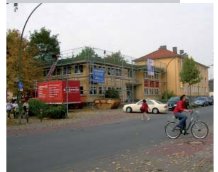
Friedrich-Ebert-Straße: Querungsstelle Fuß- und Radweg
