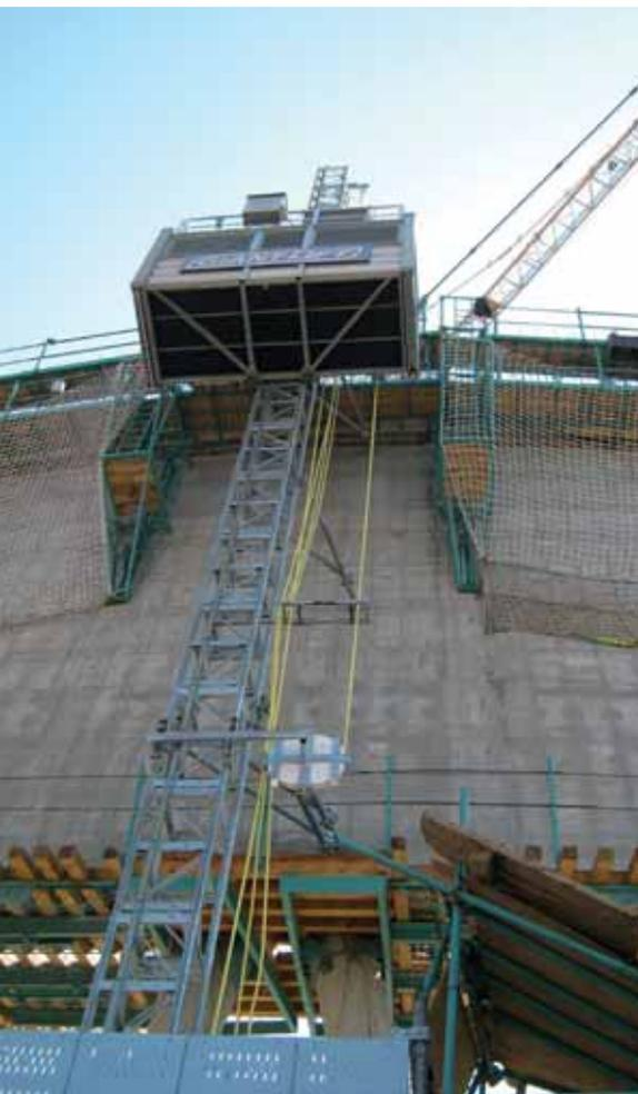
Bei der Errichtung eines 120 Meter hohen Kühlturms in der Türkei kommt ein Aufzug von Böcker zum Einsatz
