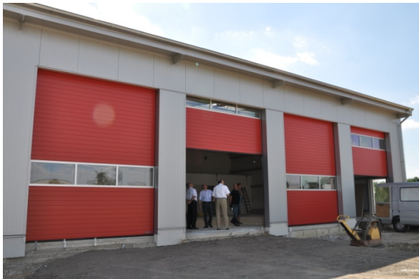
Neubau Feuerwehrgerätehaus Aminghausen-Päpinghausen
