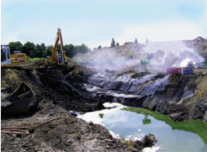
Zur Minimierung der Geruchsbelästigung werden Sprühnebelkanonen eingesetzt
