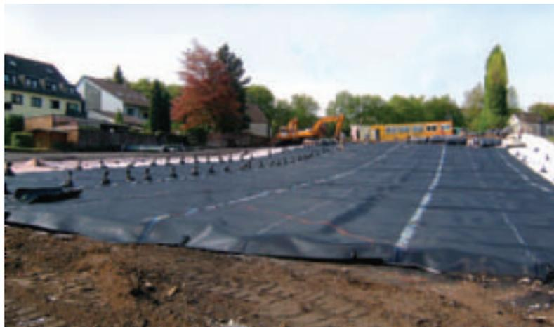
*Verlegung der Kunststoffdichtung*
