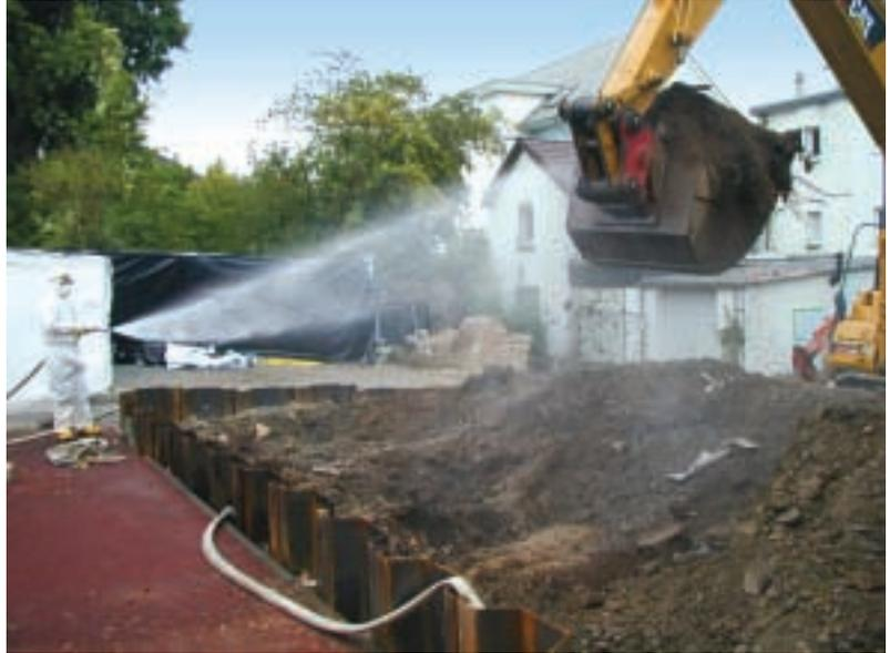
*Beregnen des Aushubs als Schutzmaßnahme gegen Staubbelastung*
