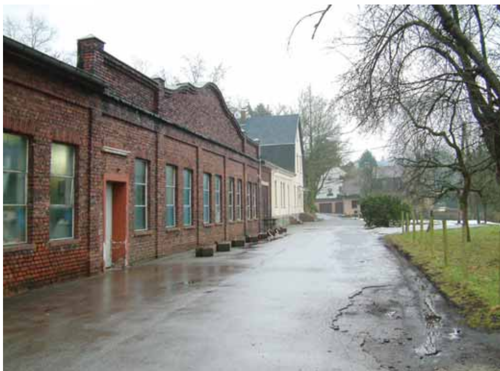
Produktionsgebäude einer Galvanik
