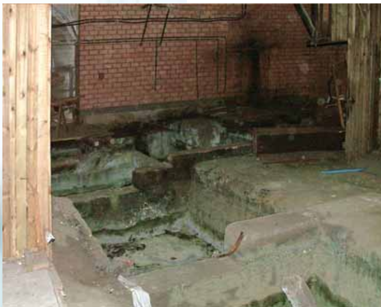
Innenansicht der ehemaligen Imprägnier-/Sägehalle
