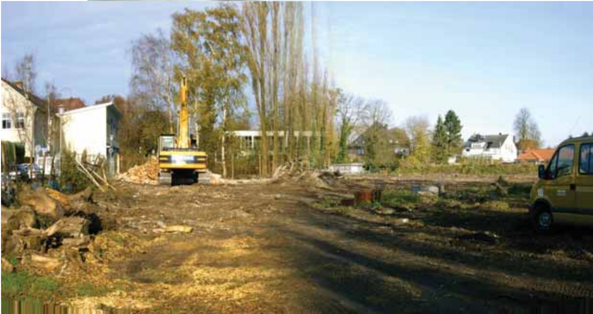
Abbildung 1: Abbruch des ehemaligen Wohnhauses und Rodung der Vegetation
