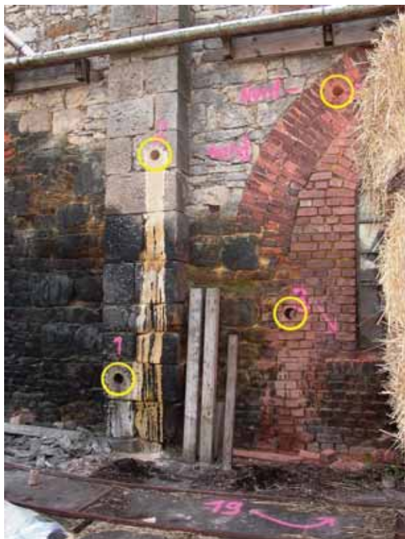
Baustoff- beprobung durch Bohrkern- entnahme
