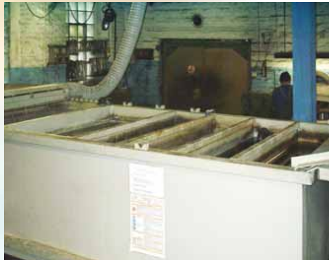
Galvanikbäder im Produktions- gebäude
