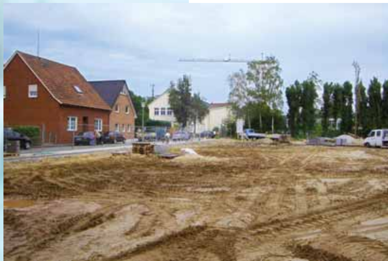
Abbildung 5: Wiederverfüllung und Profilierung des Geländes
