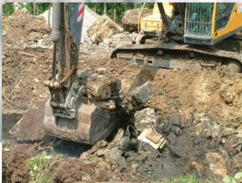
Abbildung 3: Auskoffung der kontaminierten Bodenmassen
