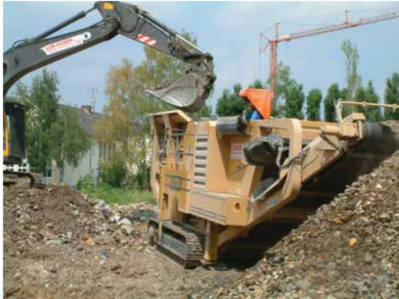
Abbildung 4: Zerkleinerung der Fundamentreste sowie des Bauschutts in einer Brecheranlage vor Ort
