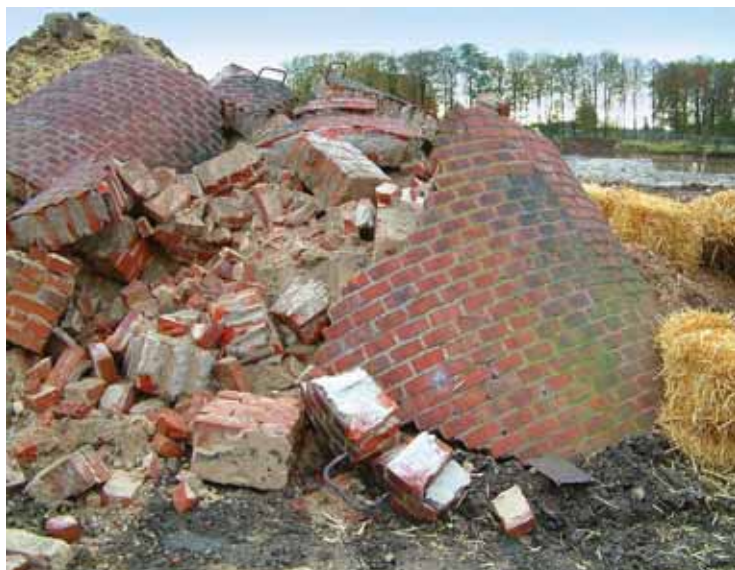
Der Kamin wurde im November 2005 gesprengt
