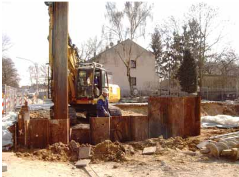
Abbildung 3: Rammung der Spundwand
