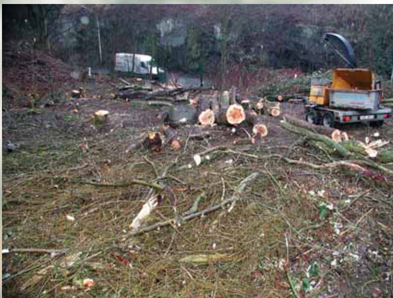
Abbildung 3: Rodung des stark bewachsenen Geländes
