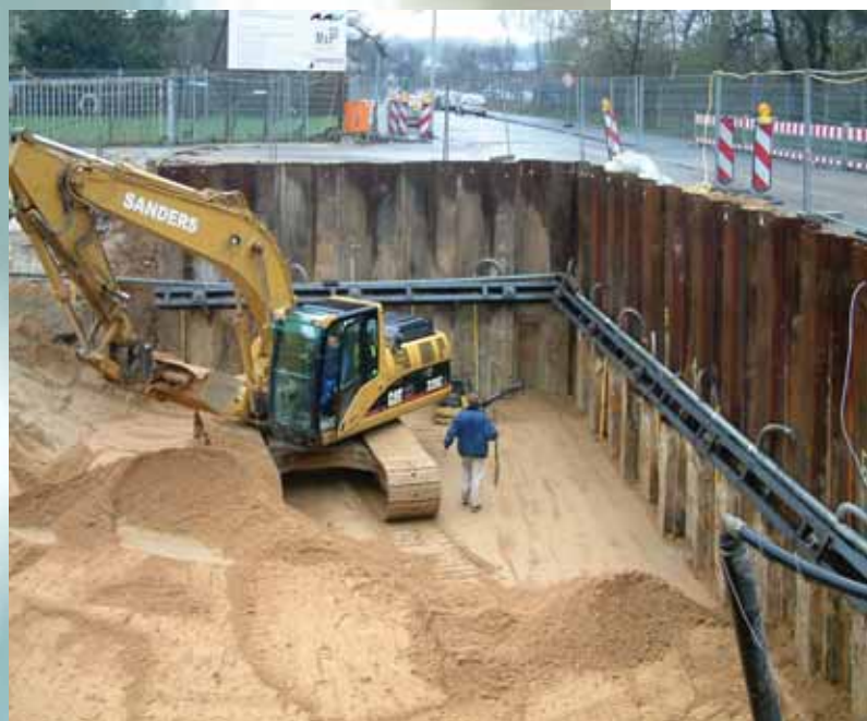
Abbildung 4: Lagenweise Verfüllung mit sauberem Boden
