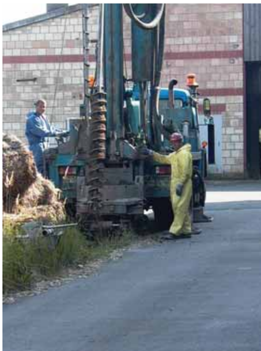
Errichtung von Grundwassermessstellen auf dem Gelände
