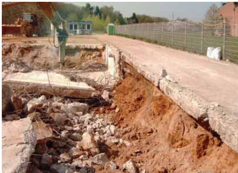
Abbildung 2: Tiefenentrümmerung der Fundamente
