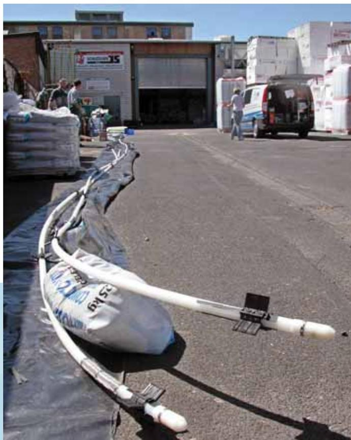
Oben und unten: Vorbereitung des CMT-Systems für den Einbau mit vorgefertigten Filterpackungen
