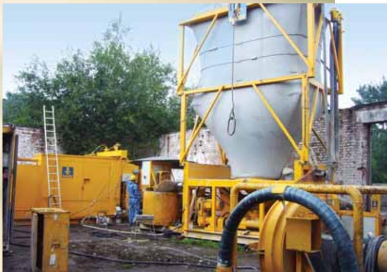
*Ein Teil der Baustelleneinrichtung für das Düsenstrahlverfahren*
