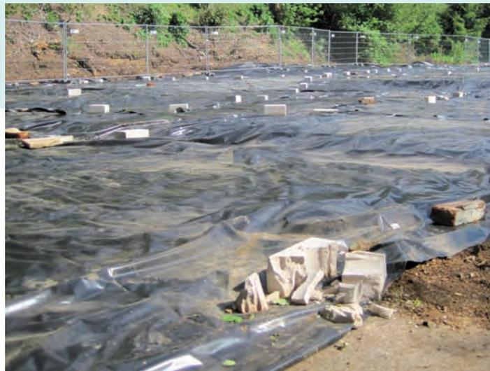
■ Standort nach Rückbau des Betriebsgebäudes. Die Bodenplatte ist mit Folie abgedeckt, um ein Eindringen von Niederschlagswasser in den hoch kontaminierten Boden zu vermeiden
