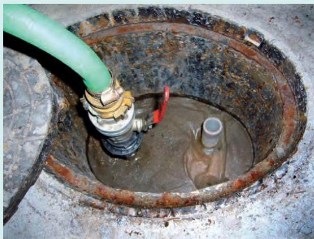
Im Bereich des Pilotversuchs wurden drei tiefenhorizontierte Infiltrationspegel erstellt, um die Melasselösung in den Tiefenbereichen von 2,0 – 3,0 bzw. 4,0 – 5,0 m unter GOK einbringen zu können. In diesen Bereichen befinden sich die wesentlichen Mengen der noch vorhandenen Restkontaminationen an chlorierten Kohlenwasserstoffen.
