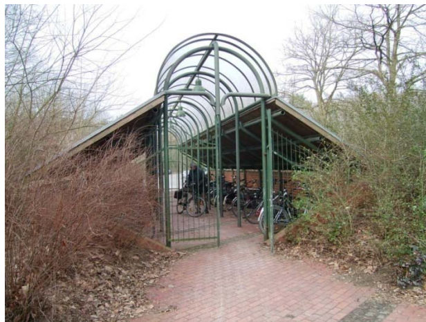
Überdachte Fahrradabstellanlage am Kreishaus Borken
