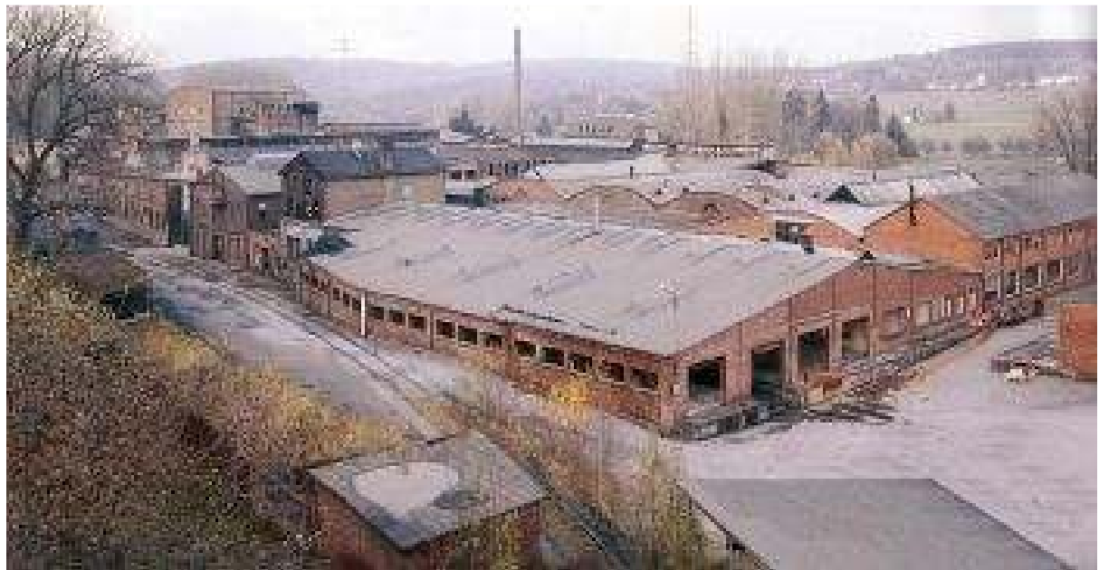
Abbildung 8: Das Betriebsgelände der Eisenwerke Rödinghausen
