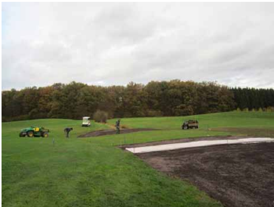
Der Golfclub Münster-Tinnen arbeitet weiter an der Optimierung seines Platzes. An den Löchern 14 und 18 wurden jetzt die quer verlaufenden Gräben aufgefüllt.
