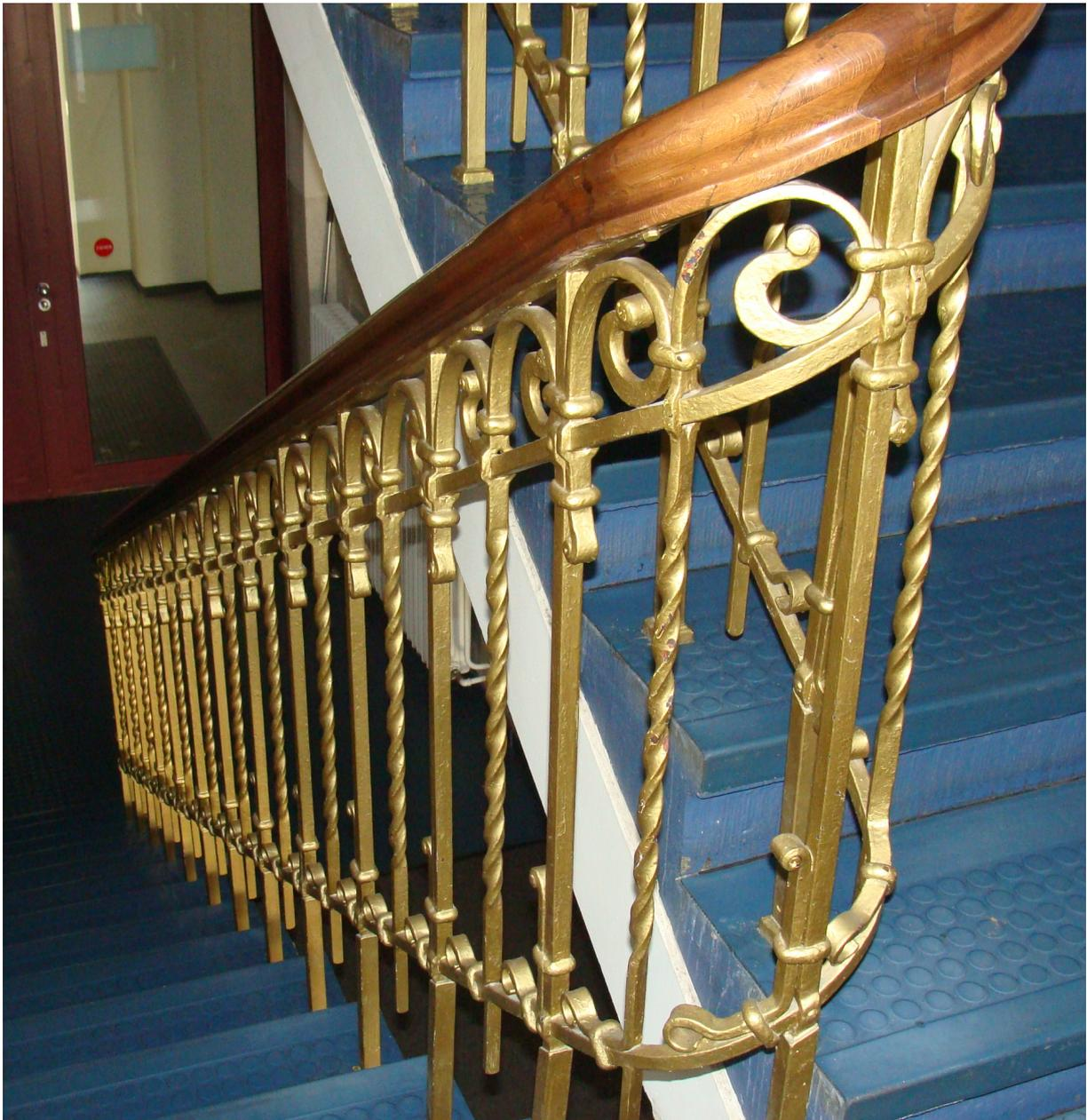
**Bei der von September 1992 bis Herbst 1994 mit einem Aufwand von 4,7 Millionen DM durchgeführten Innensanierung wurde jede einzelne Stütze des schmiedeeisernen Geländers verlängert, um die Forderungen des Denkmalschutzes und der Bauvorschriften bezüglich der Höhe des Geländers zu erfüllen.**
