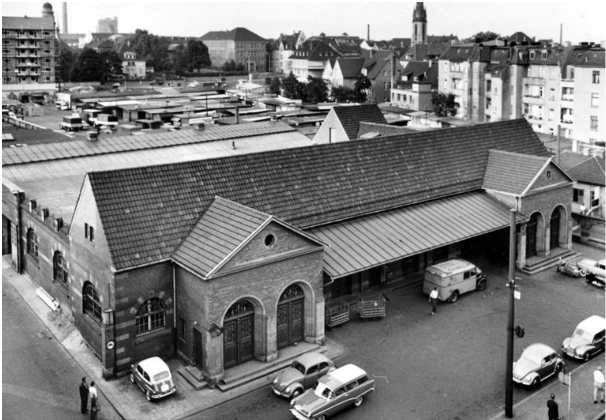
Paketkammer des Postamtes Bielefeld an der Friedrich-Ebert-Str.. Wurde Ende 1965 abgerissen, um Platz für den Neubau des Techniktraktes zu schaffen. Foto: Freie Presse (Borowka) zum Artikel vom 29. Juli 1959.
