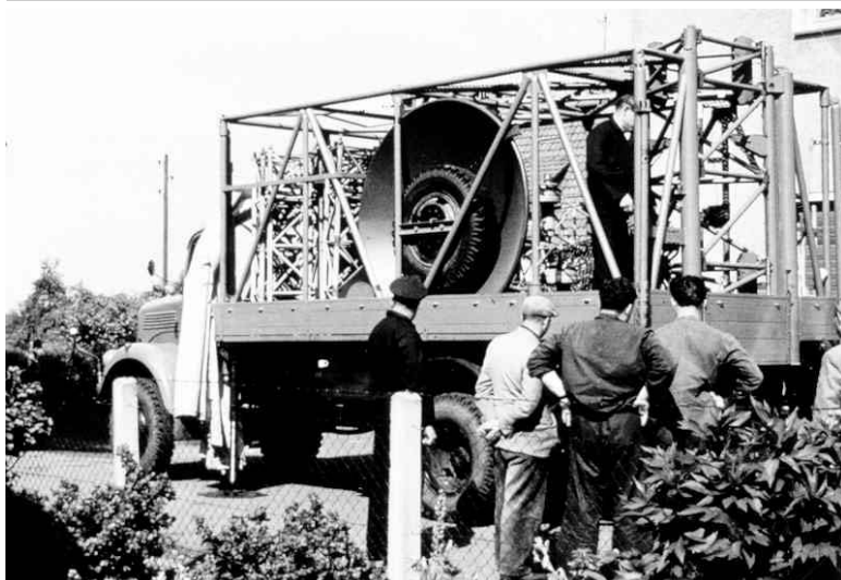
09.00 Uhr, der Lkw mit dem mobilen Mast trifft ein.
