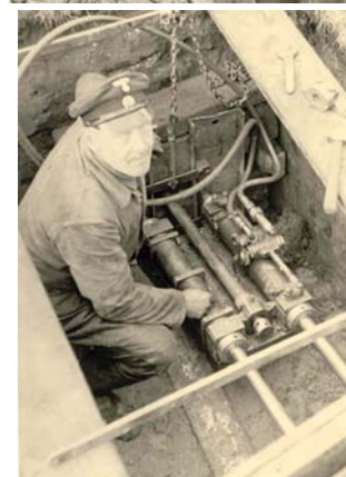
Einsatz des Stossbohrgerätes an der Steinhäger Str. in Bielefeld/Quelle im April 1949.
