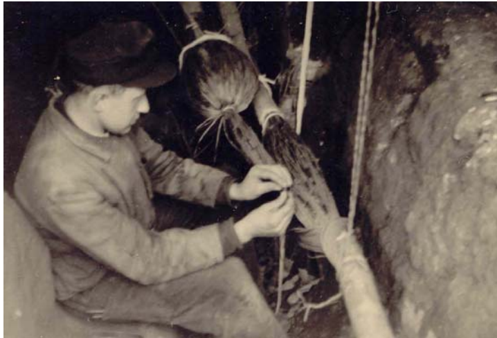
Instandsetzungsarbeiten an einem hochpaa- rigen Kabel in Bielefeld. 1949.
