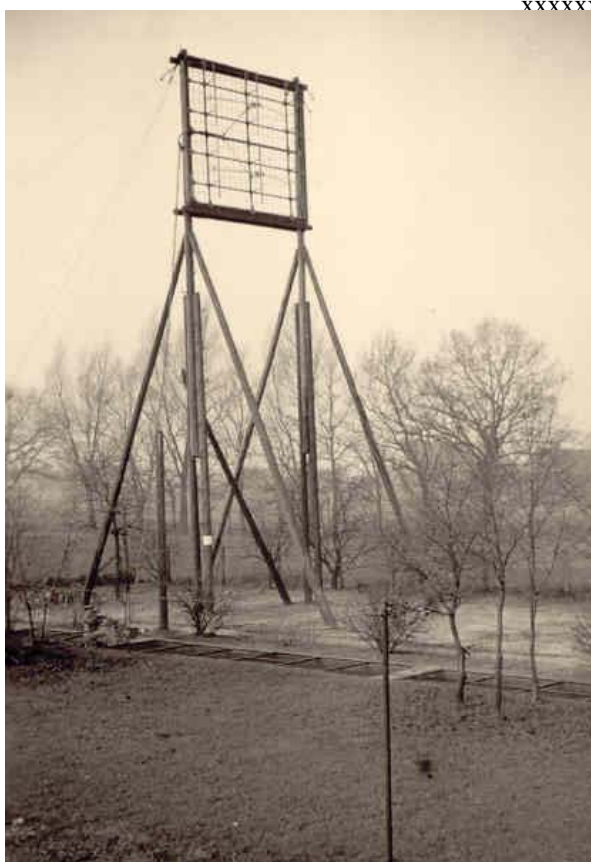
Verstärkeramt Wiedenbrück (St. Viet) im Februar 1952. 14m hohes Antennengerüst 12 UKW (175 MHz).
