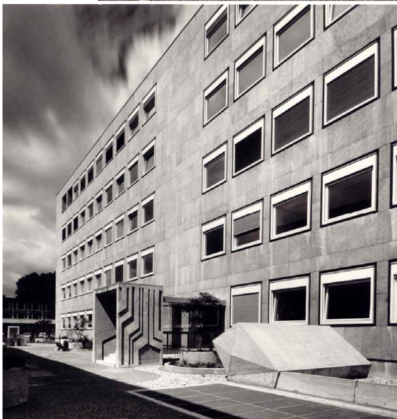
Vorderansicht des Gebäudes für die Knotenvermittlungsstelle des Fernmeldedienstgebäudes in Herford, Auf der Freiheit. Nach der Fertigstellung 1970.
