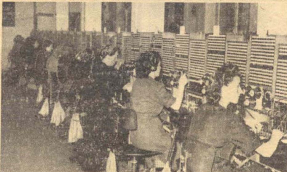
„Hallo, Fernamt! Fräulein, verbinden Sie doch mal!“ Hier läuft noch alles mit Handbetrieb, während . . .
