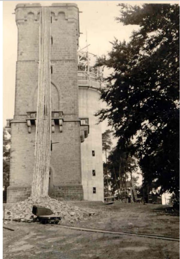
Im Vordergrund Abbruch des alten "Drei-Kaiser-Turms".
