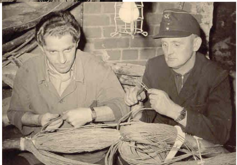
Erich Berner (links) zusam- men mit Herbert Pfeiffer bei Spleiß- arbeiten im Kabelschacht um 1950
