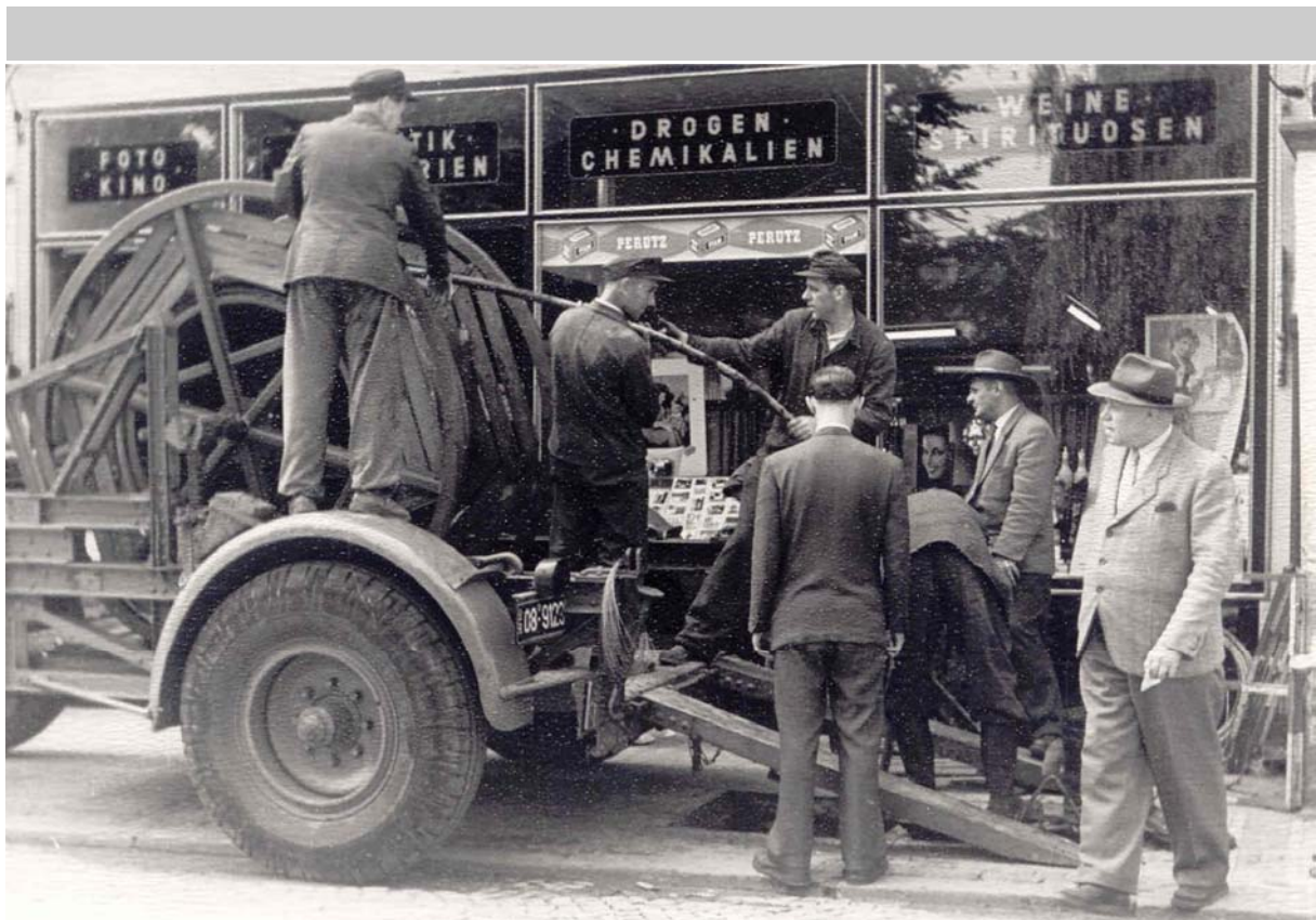
Einziehen von Röhrenkabeln in einen Kabelkanal in Bielefeld. Ein Herforder Bautrup bei der Arbeit in Bielefeld. Rechts im Bild Heinrich Gläsker (Bezirksbauführer in Herford). 3. von links: Karl Sakalautzki.
