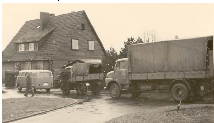
Am 30. Dezember 1966 verlassen die letzten Postfahrzeuge den Mönkeberg.
