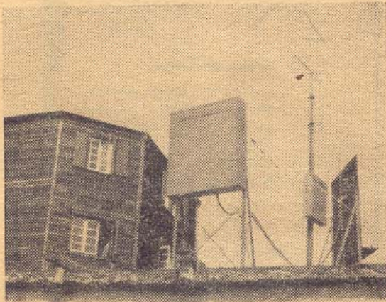
Durch diese „Kisten“ Foto: T-A-H neben dem Köterberghaus wird drahtlos telefoniert.
