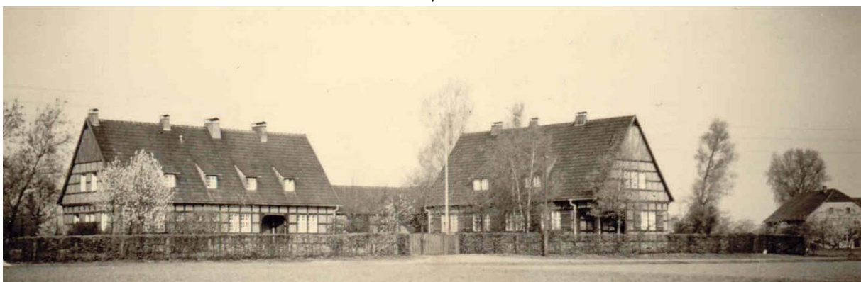
Verstärkeramt Wiedenbrück (St. Viet) im April 1953. Betriebsgebäude links, Wohngebäude rechts.
