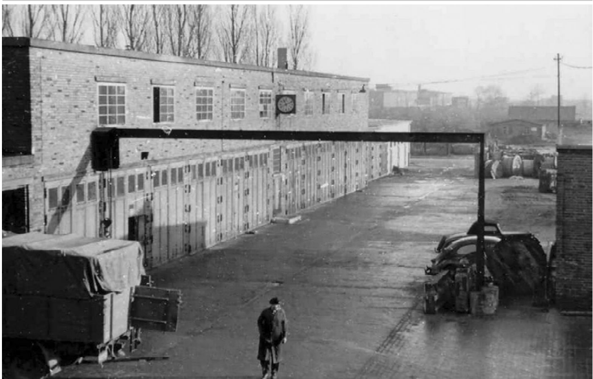
Hinter den großen Türen wurden die Fahrzeuge der Bautrupps abgestellt und hier lagerten sie ihr Material (Kabel, Bronzedrähte, Sprechstellenapparate, Werkzeug usw.). In den Räumen darüber befanden sich die Büros für die Bautruppführer und die Umkleideräume der Handwerker.
