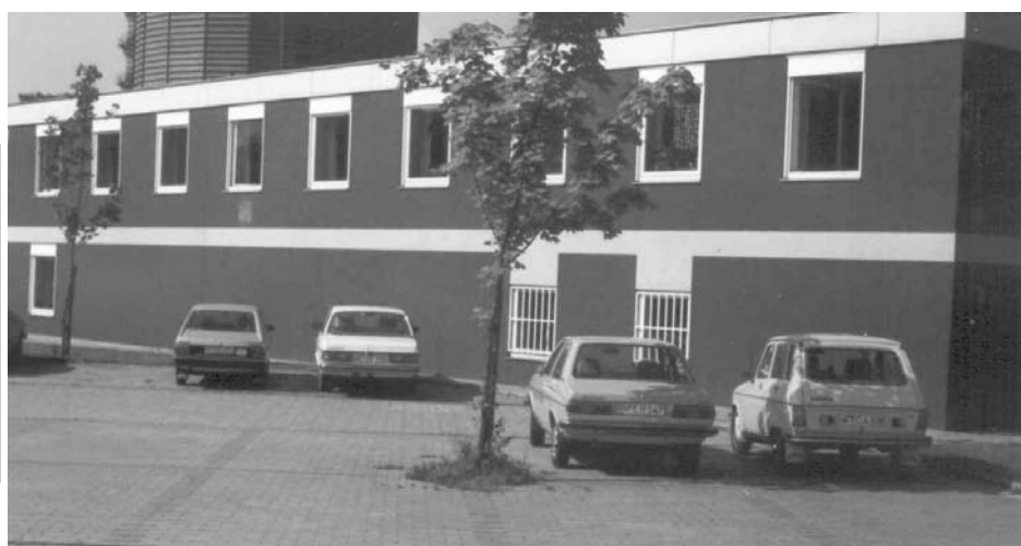
Gebäude für zwei Bielefelder Fernmeldebaubezirke an der Beckhausstraße. Im Hintergrund der später abgebrochene Gasometer der Stadtwerke Bielefeld. Foto April
