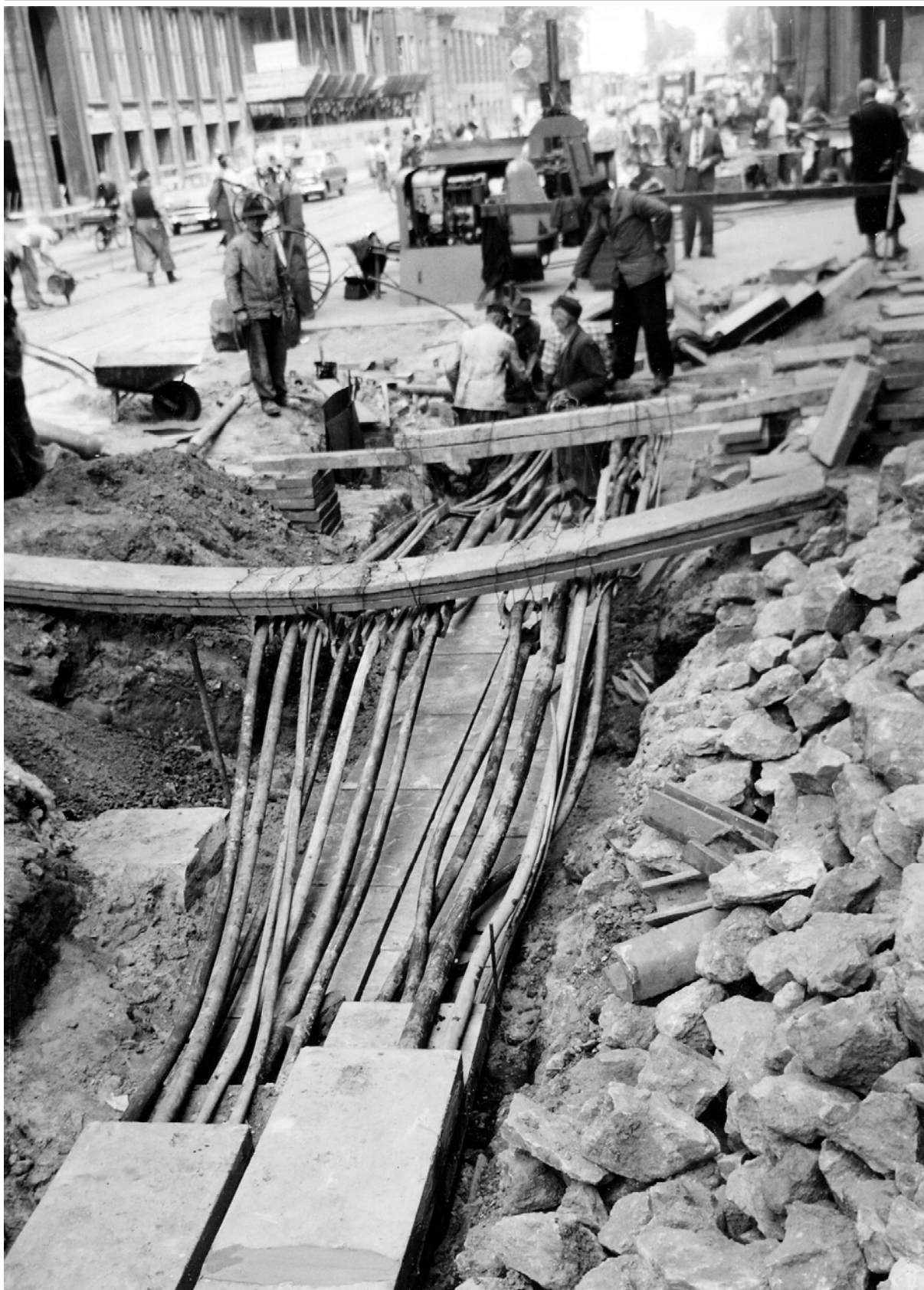
Arbeiten am Kabelkanal Friedrich-Ebert-Straße Ecke Herforder Straße (vor dem Postamt). Stadtarchiv, Foto. Möller, 1955.
