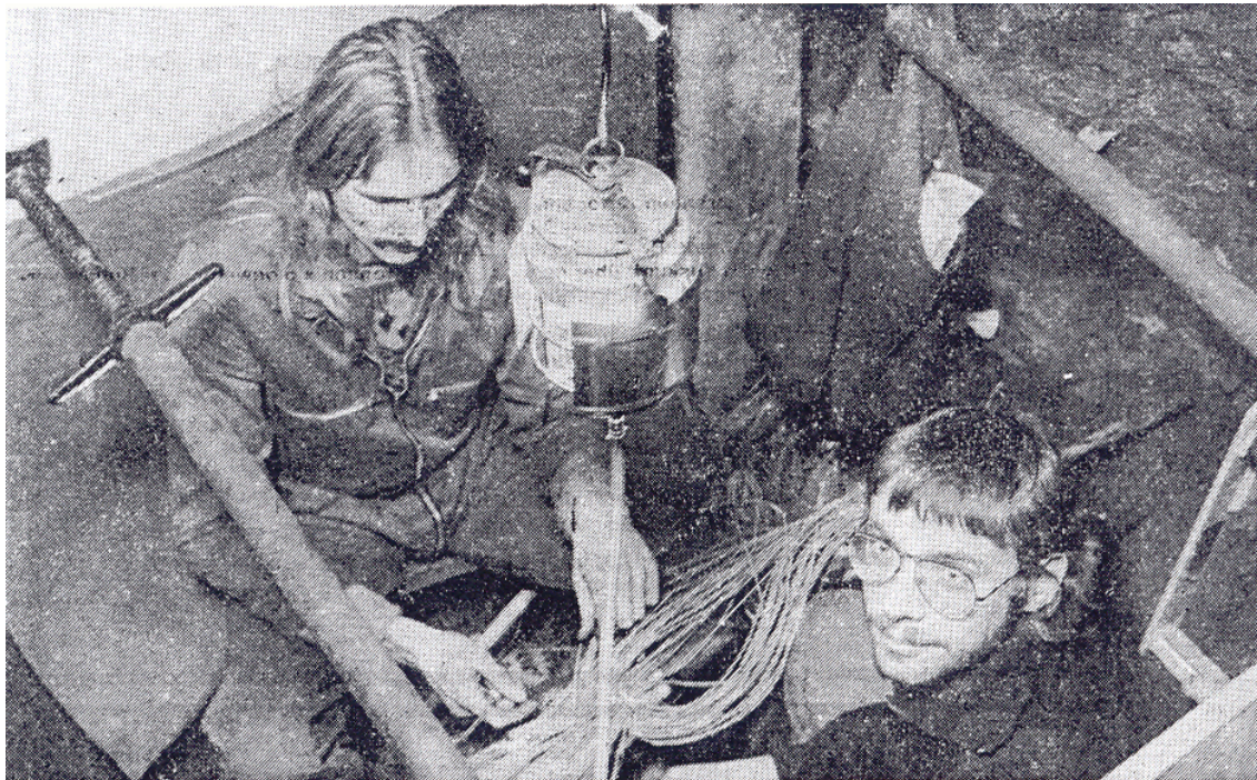
Über 1200 Telefonanschlüsse aus der Südstadt müssen die Techniker des Bielefelder Fernmeldeamtes „unter der Erde“ am Hauptkabel der Bleicherfeldstraße umschalten. Die Arbeiten sollen am 11. Januar beendet sein. Foto: Saake
