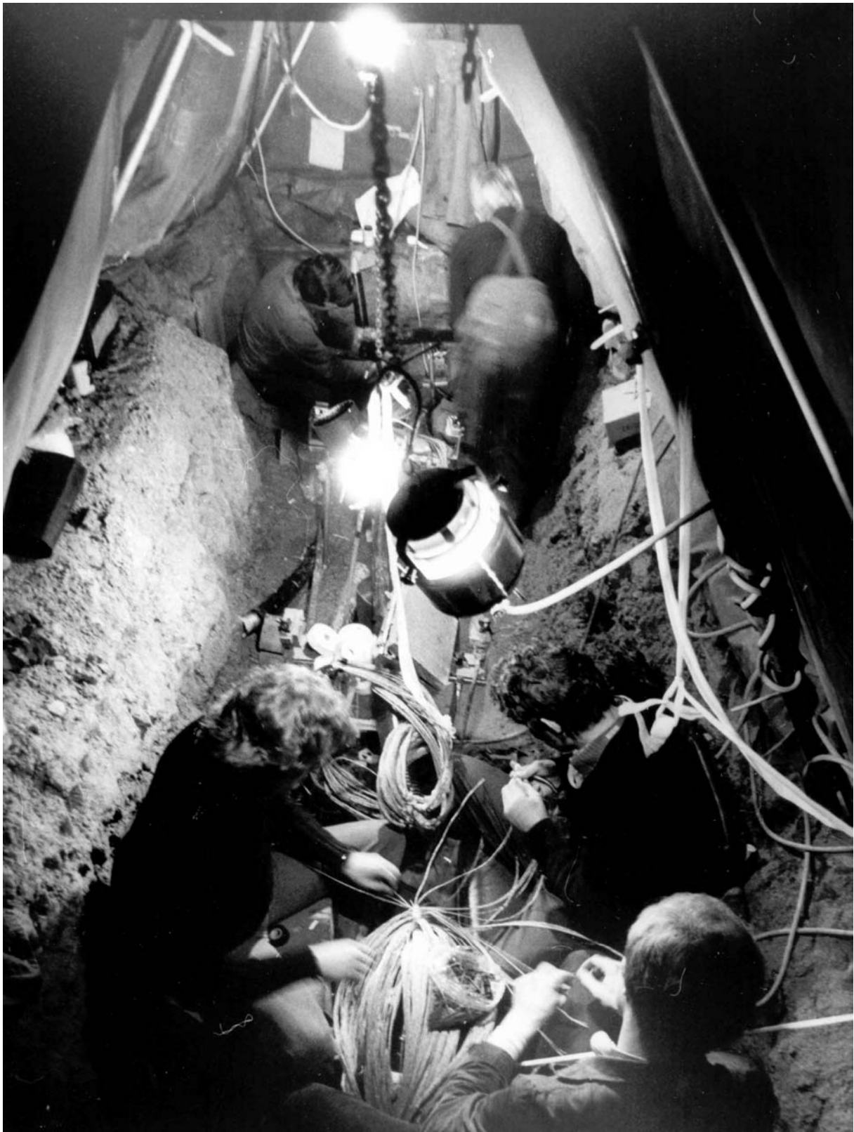
Beseitigen eines Kabelfehlers.
