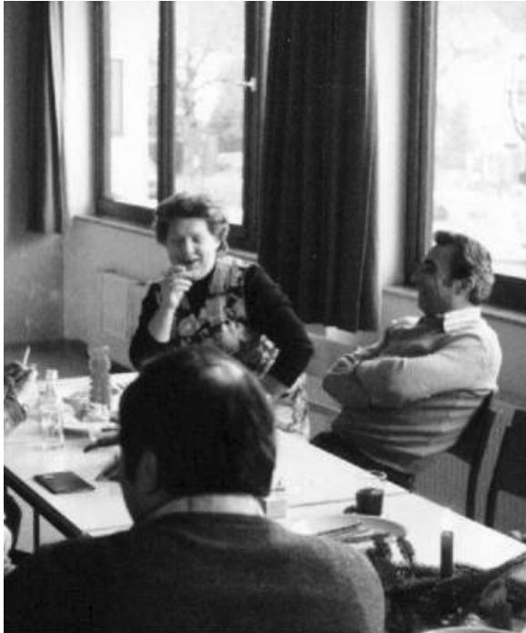
Im Aufenthaltsraum des Fernmeldebaubezirkes 21 an de Flensburger Straße. Per Rückenansicht ist Hubertus Kahler (Bauführer) zu sehen. Rechts sitzt Reiner Brückner (Disponent) und links von ihm Frau Strunk
