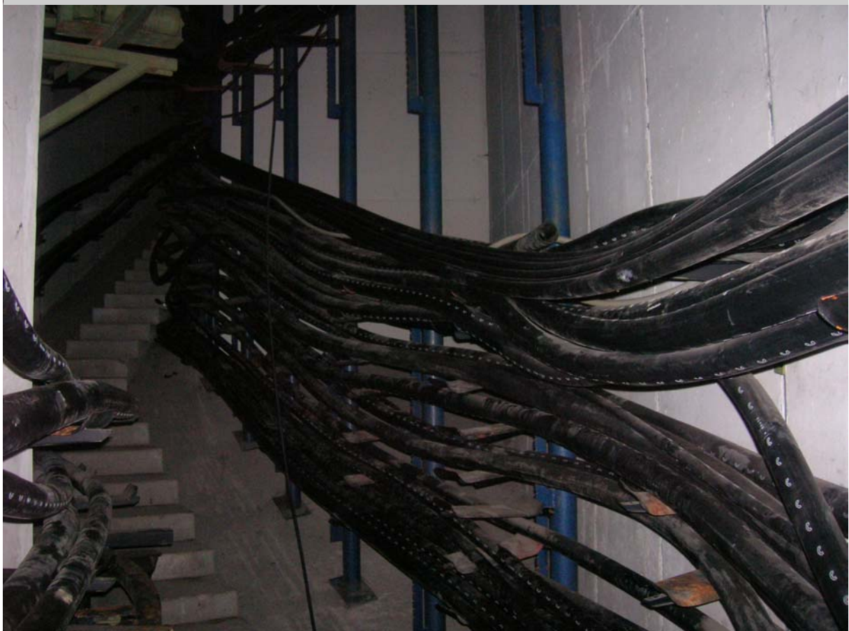
Aufnahme vom 06. Juli 2006 im Kabelaufteilungskeller Bielefeld Mitte. Kabelzuführung vom Einführungsschacht in den Kabelaufteilungskeller.
