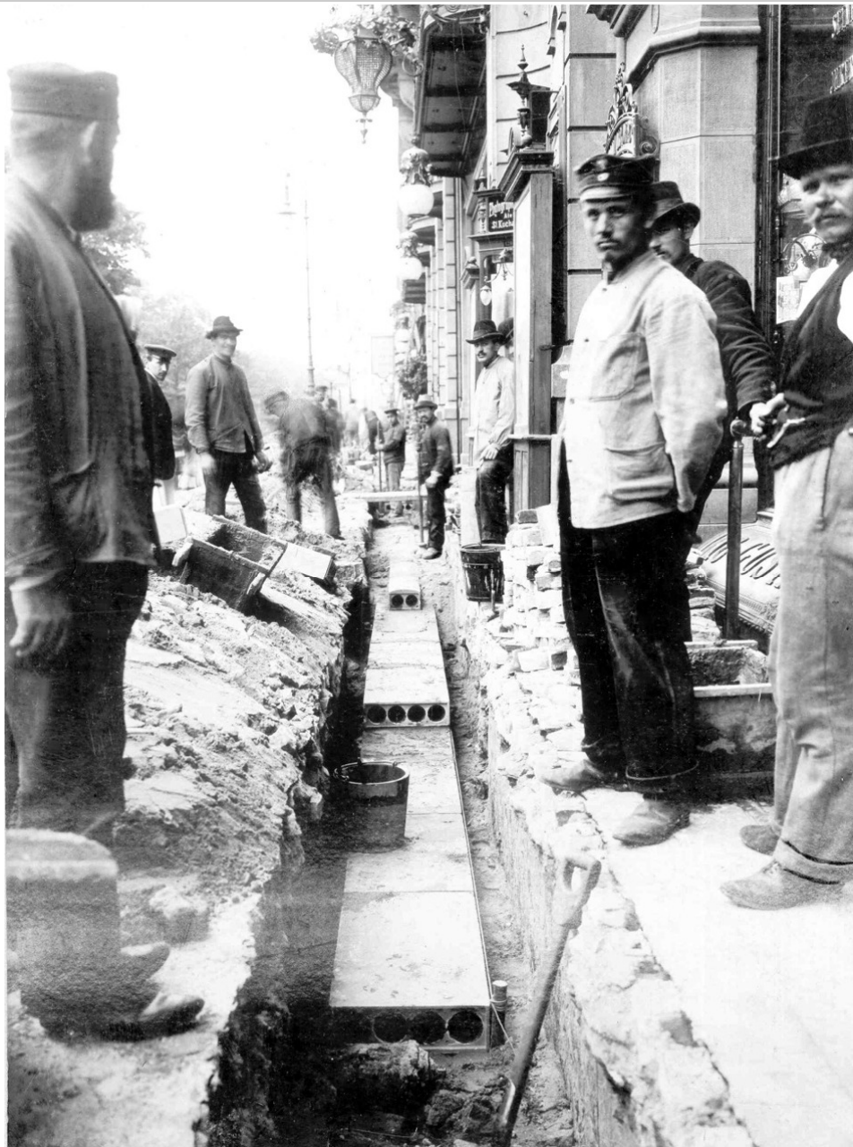
Verlegen der Kabelkanalformsteine. Foto vom Bau des Kabelkanals für das „Rheinlandkabel“.
