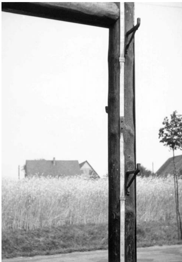
Überföhrungsendverschluss Bauart 1950, Sicherungs- und Schaltraum.
