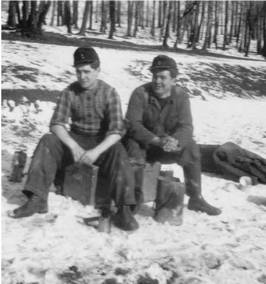
Kabellöter des Bautrupps Kleine-Benne im Februar/ März 1952 in Olderdissen. Harald Ullrich (links) und Karlheinz Plöger.
