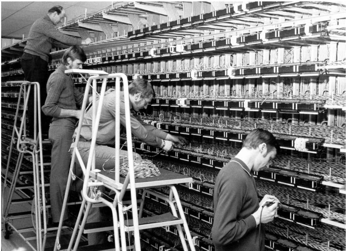
Foto von Schaltarbeiten am Hauptverteiler im neu gebauten Technik-Trakt in Bielefeld am 16. März 1972 aus Anlass der Einschaltung der neuen Ortsvermittlungsstelle Bielefeld-Mitte. Von links: Willi Reimann Baubezirk 23 Bielefeld (verantwortlich für die Umschaltung), Stühlmeier (Baubezirk Bad Oeynhausen), Saueressig (Fernsprechentstörungsstelle Bielefeld), Meier (Baubezirk Bad Oeynhausen). Foto: Ed. Heidmann vom Westfalen-Blatt.
