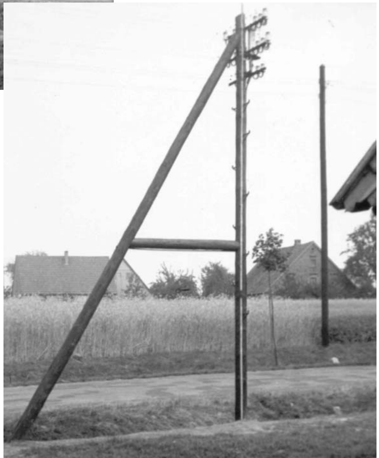
Überführungsendverschluss Bauart 1950 mit hochgeschobener Haube.
