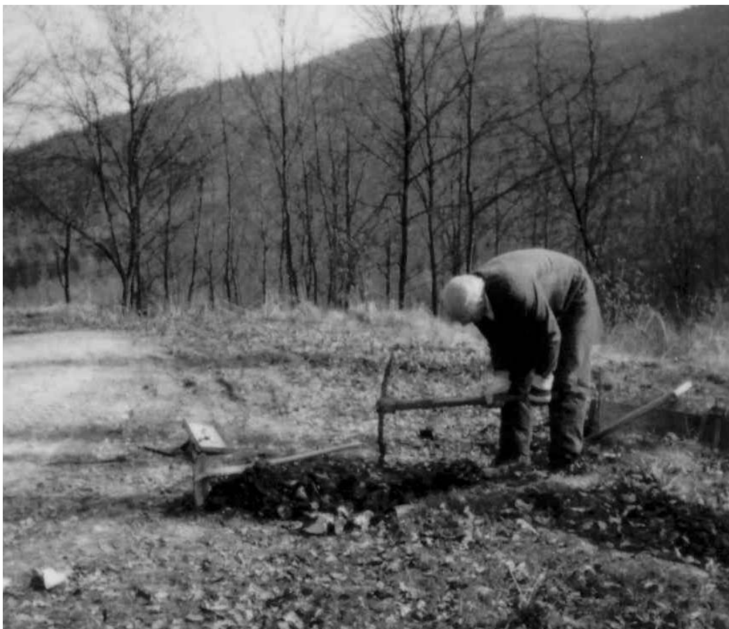
Fernkabel- baustelle des Fern- meldeamtes 1 Bielefeld. 09. April 1992. Her- bert Hilke- meier beim Setzen eines großen BP- Steines am Fernkabel 249002. Oben im Hinter- grund auf dem Foto ist der Sockel des Kaiser- Wilhelm- Denkmals an der Por- ta Westfali- ca zu sehen.
