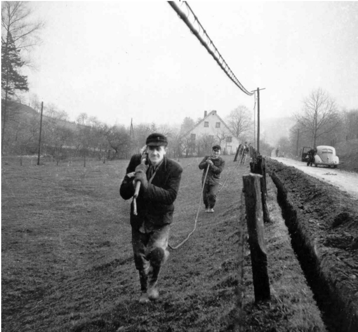
Bautrupp Halle. "Versenken des Luftkabels" Halle-Werther im Nov. 1953. 2. Willibald Richter.
