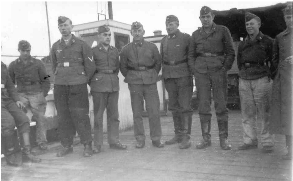
Bautrupp Halle. Auf einer Fähre beim Übersetzen über die Maas im März 1940. Von links. 3. Bentlage, 4. Gustav Goth, 5. Vorarbeiter August Lohmann.
