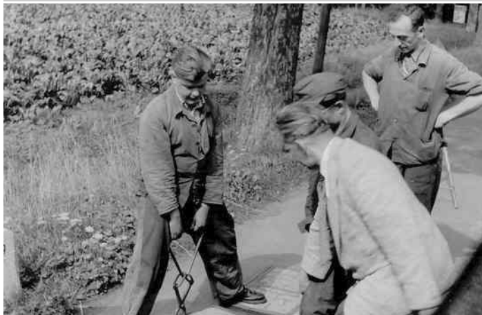
Fernkabelbautrupps des Fernmeldebauamtes Bielefeld am Kabelkanal des „Rheinlandkabels“ an der Bundesstraße 61 zwischen Bielefeld und Gütersloh, etwa 1952/1953. Da die Anlage nicht, wie noch bis zu Anfang des 2. Weltkrieges, regelmäßig gewartet wurde, waren die Dränaugen verstopft und nach dem Öffnen des Schachtes musste erst das Wasser herausgepumpt werden.
