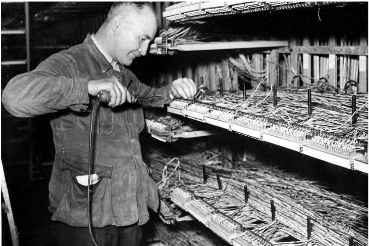
Schaltarbeiten an der waagerechten Seite des Hauptverteilers in Bielefeld-Mitte. Foto: Möller, 1950.
