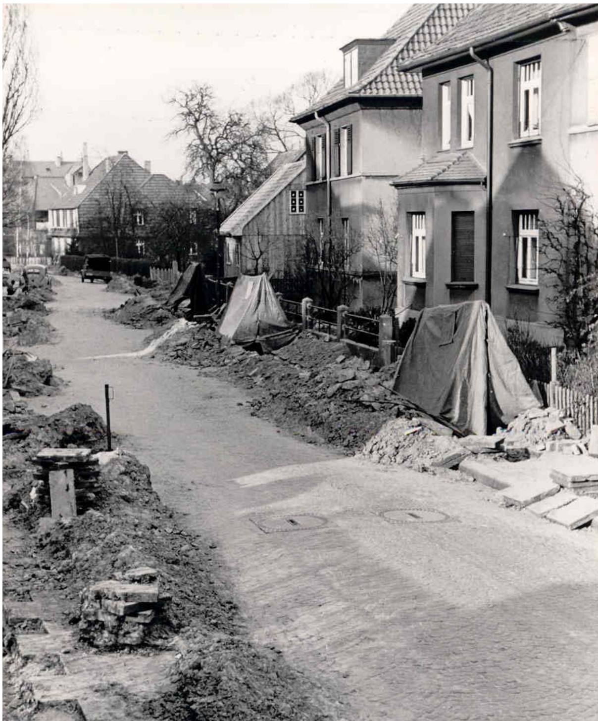
Auslegen von Kabeln am Am Tiefen Weg in Bielefeld Richtung Westen (17. 02. 1950) . Foto Stadtarchiv.
