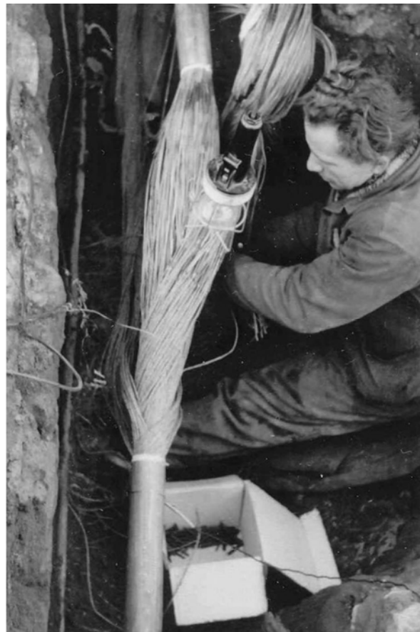
Instandsetzungsarbeiten an einem hochpaarigen Kabel in Bielefeld.
