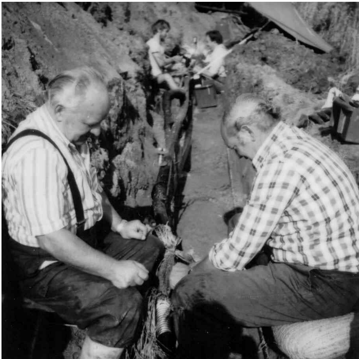
Fernkabelbaustelle des Fernmeldeamtes 1 Bielefeld etwa 1977/1978. Fehlerbeseitigung an einem Bezirkskabel. Im Vordergrund Gerd Nabereit (links) und Herbert Hilkemeier.
