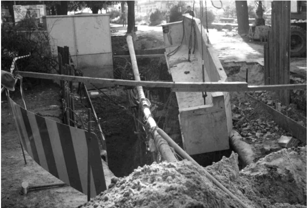
Längsgeteilte Fertigschächte mussten verwendet werden, wenn sie in eine vorhandene Kabelkanalanlage mit Kabeln eingebaut werden sollten.
