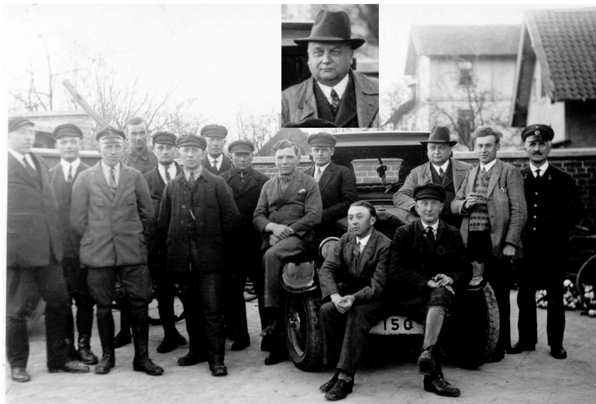
Bautrupp Halle. Von links: 1. G. Horstmann, 7. Vorarbeiter August Lohmann, 8. Heinrich Lünstroth, 10. Heinrich Brune. 3. von rechts mit Hut Bezirksbauführer Knöner. Knöner leitete den für die Zeit von 1930 bis 1935 gebildeten Baubezirk Gütersloh.
