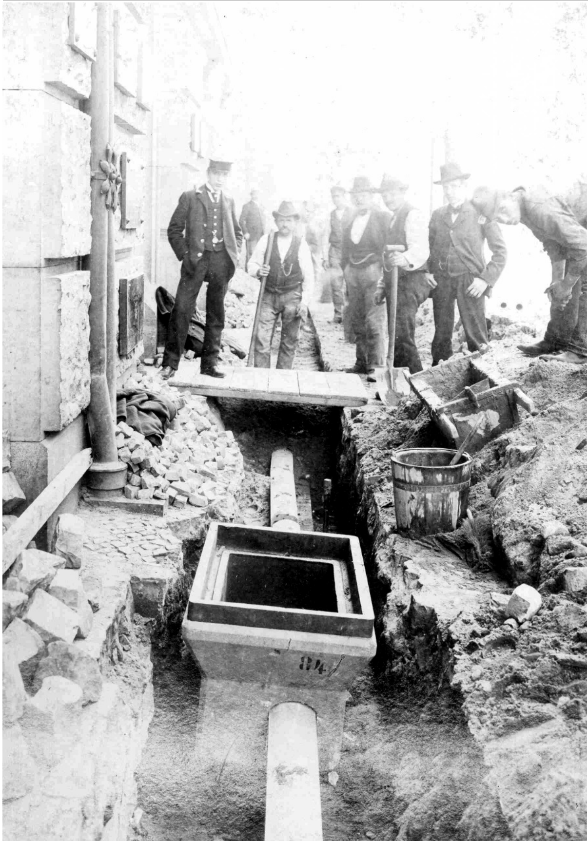
Einbau eines Abzweigkastens. Foto vom Bau des Kabelkanals für das „Rheinlandkabel“.
