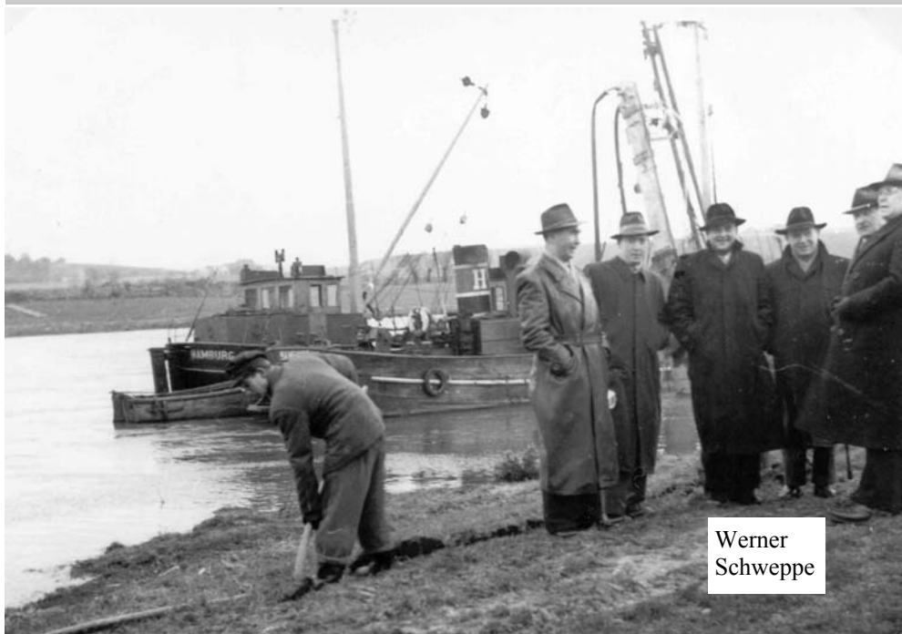
Kabelverlegearbeiten durch die Weser bei Vennebeck 1955. Die Bezirksbauführer von links: Karl Klopsch (Minden), Rudolf Beermann (Bad Oeynhausen), Werner Schweppe (Detmold) , Wilhelm Kampe (Bezirksbauführer-Vertreter), Stobius (OPD Münster), Heinrich Gläsker (Herford).
