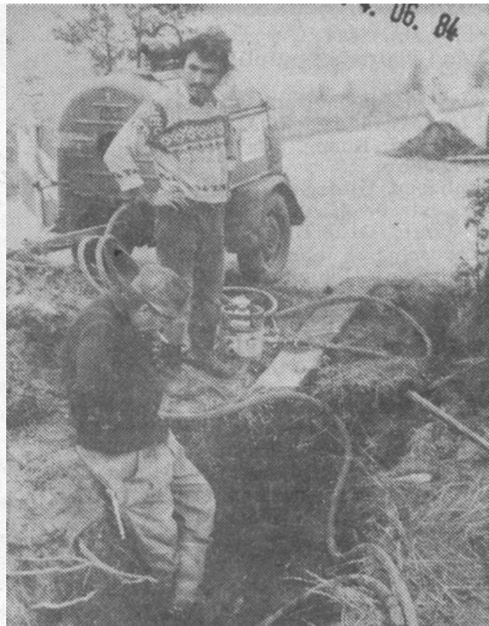
Rund drei Kilometer längs der Ströher Straße in Steinhagen laufen die ersten Arbeiten für das Bundespost-Versuchsprojekt BIG-Fern und BIGFON. Die Leitungen (Foto) werden 80 Zentimeter tief eingegraben. Foto: Biedermann
