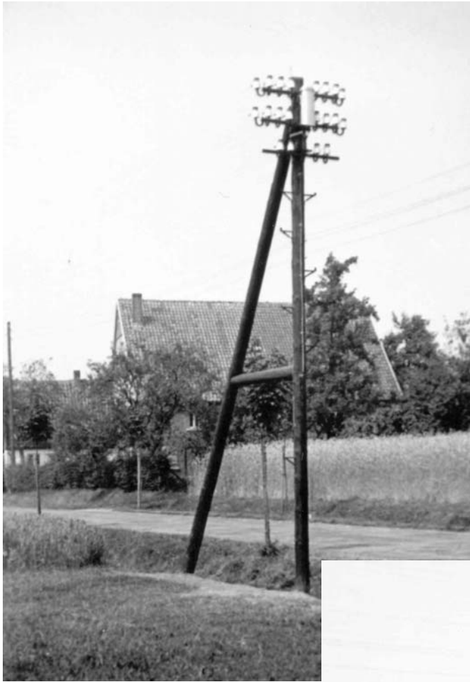
Überführungsendverschluss Bauart 1950 mit hochgeschobener Haube.
