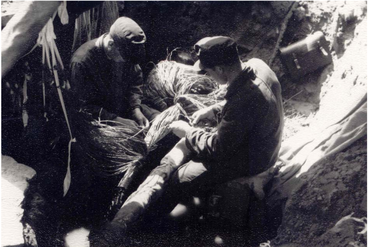
Kabellöter bei Spleißarbeiten um 1950 in Bielefeld.
