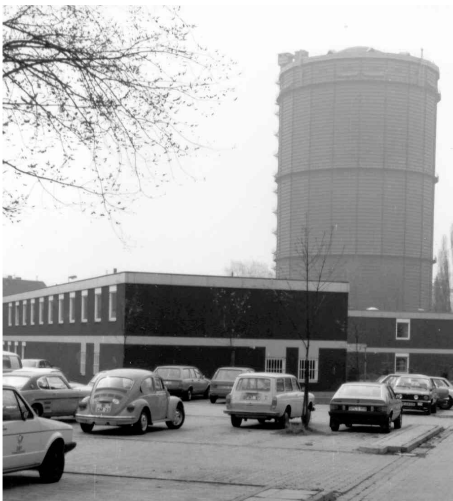
Gebäude für zwei Bielefelder Fernmeldebaubezirke an der Beckhausstraße, Parkplätze. Foto April 1979.
