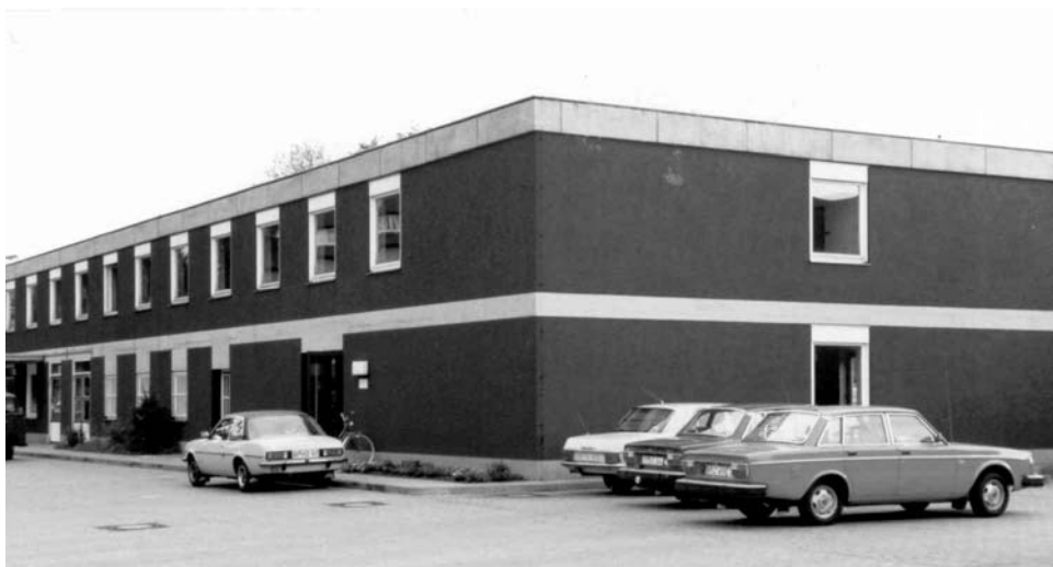
Gebäude für zwei Bielefelder Fernmeldebaubezirke an der Beckhausstraße. Foto April 1979.
