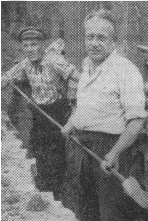
Mit dem Erdbohrer ging es unter dem Fahrdamm der Kaiserstraße hinweg.
