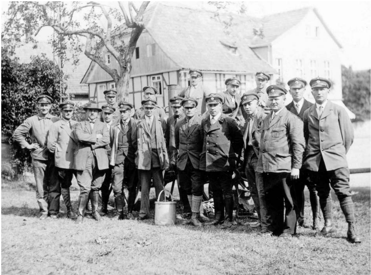
Bautrupp Halle. 2. von links: Heinrich Brune. 2. von rechts: Vorarbeiter August Lohmann.
