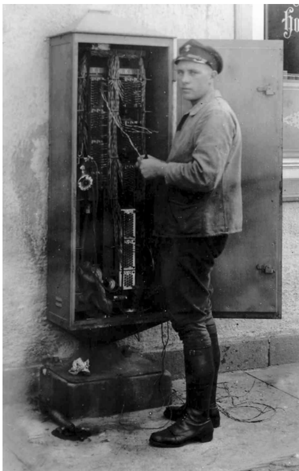
Telegrafenerbauer bei Schaltarbeiten am Ka- belverzweiger, etwa 1920.
