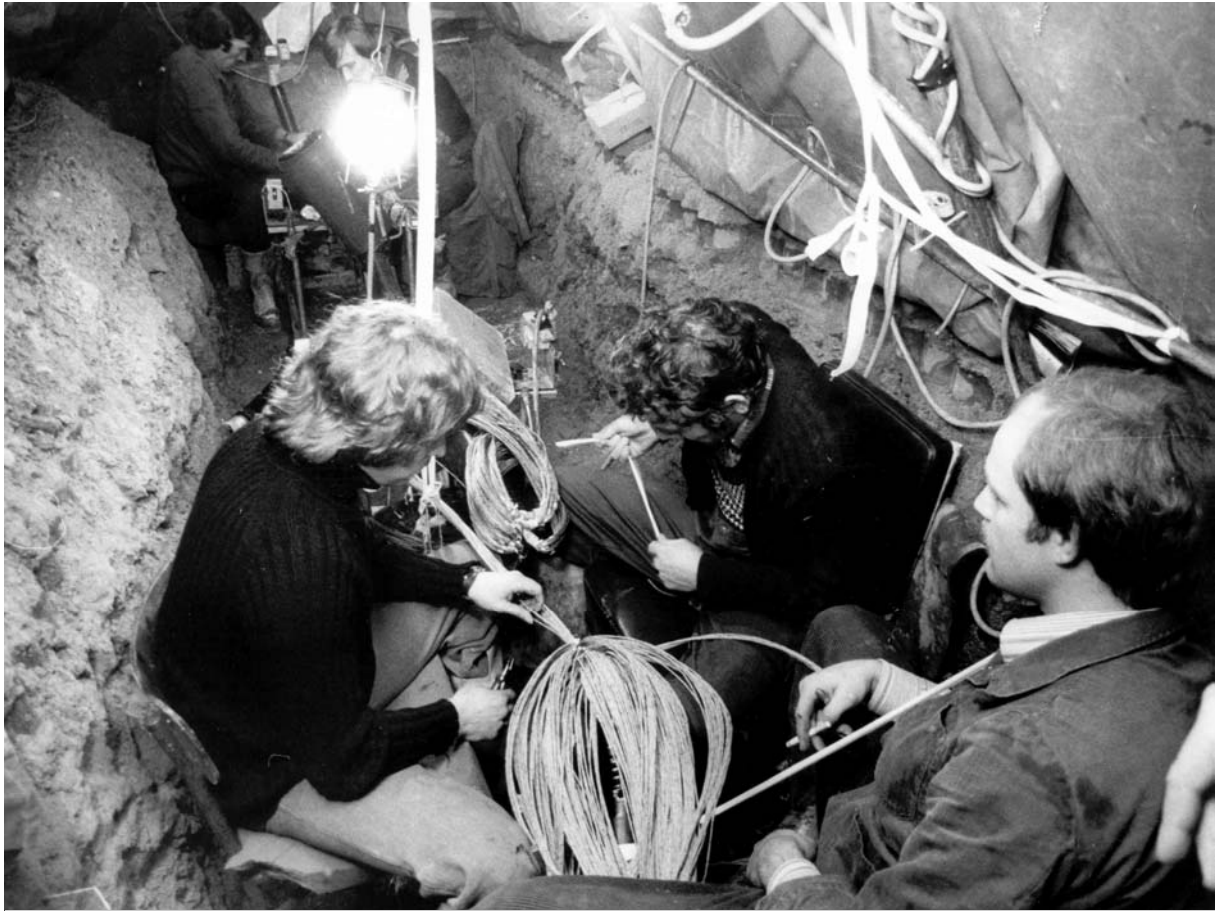
Beseitigen eines Kabelfehlers.
