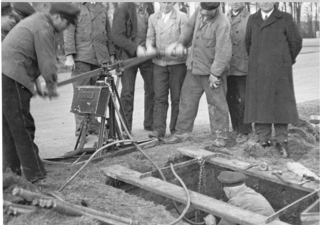
Einsatz des Stoßbohrgerätes. Foto: 1949. Von links, oberes Foto: Gerd Nabereit, Werner Zimmat, Husemann und Edmund Seidel.
