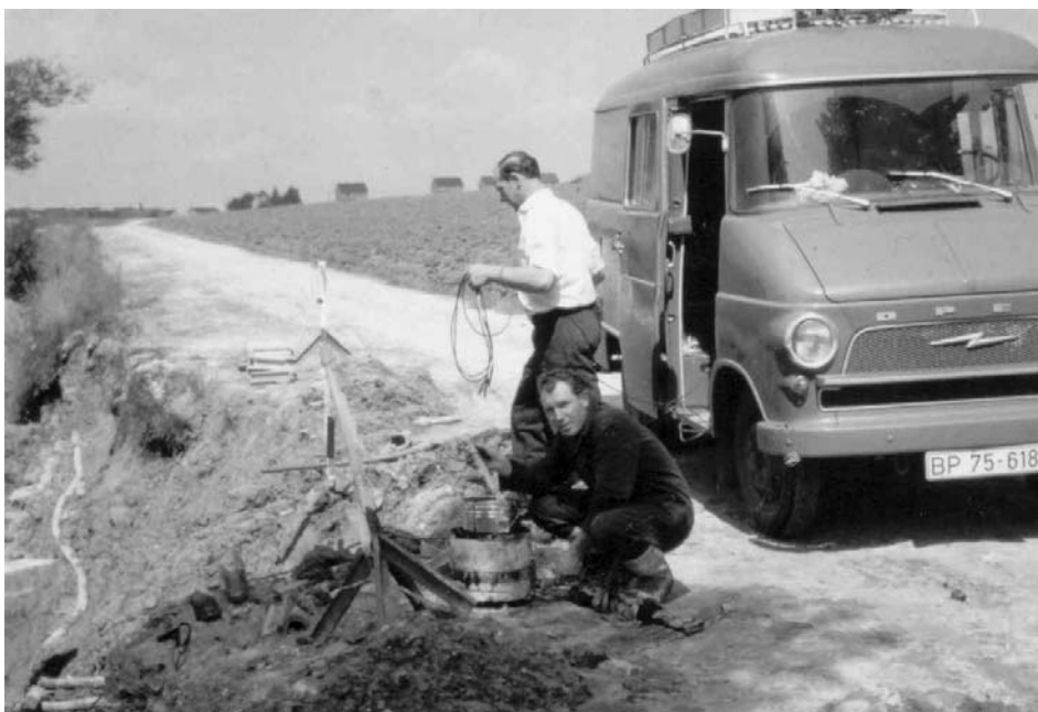
Fernkabelbaustelle des Fernmeldeamtes 1 Bielefeld. Fehlerbeseitigung an einem Bezirkskabel in Enger. Hockend: Gustav Dingersen. Dahinter Herbert Hilke-meier.
