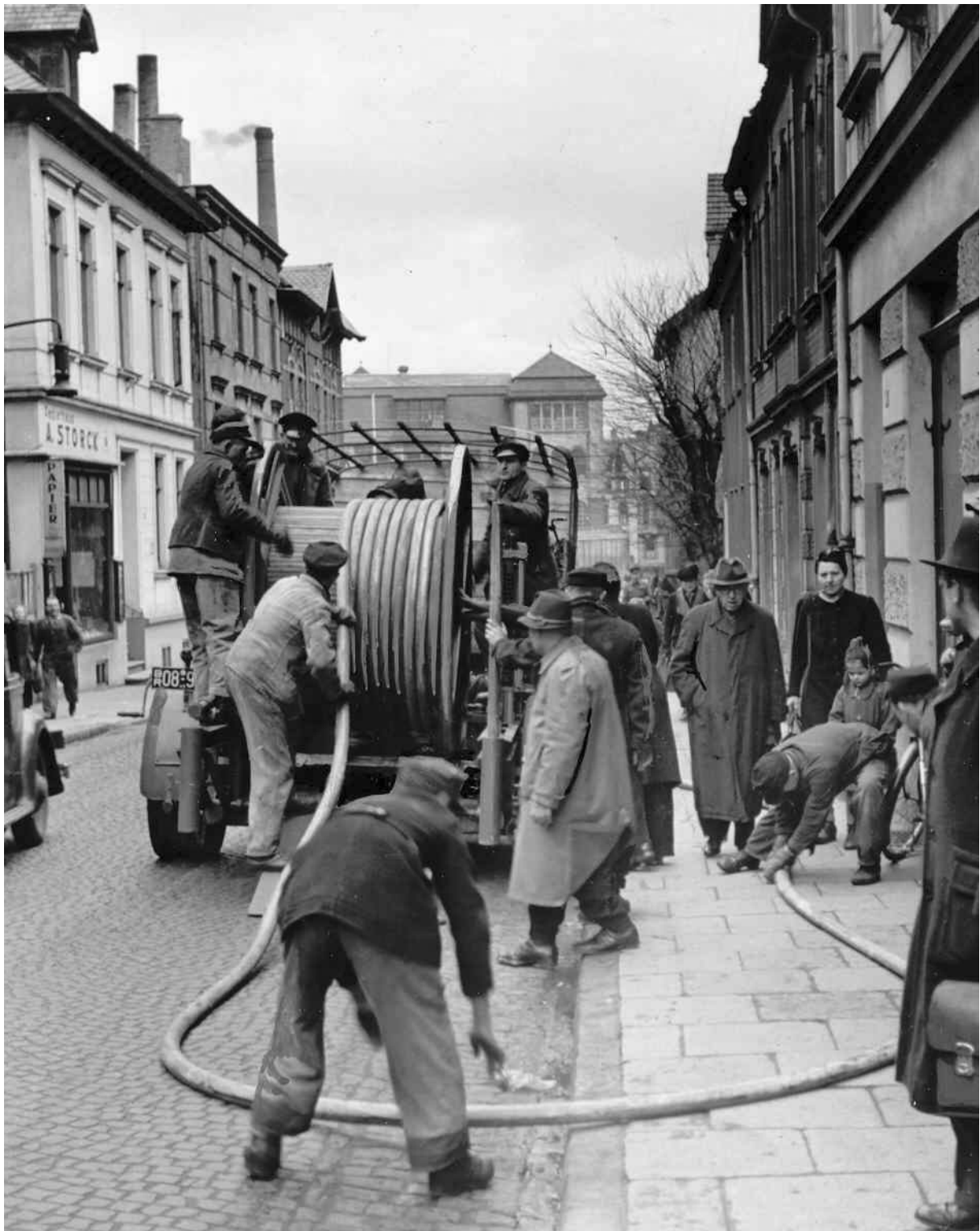
Einziehen von Röhrenkabel in den Kabelkanal bei Arndtstraße 22 in Bielefeld. Stadtarchiv Bielefeld, Foto von 1955.
