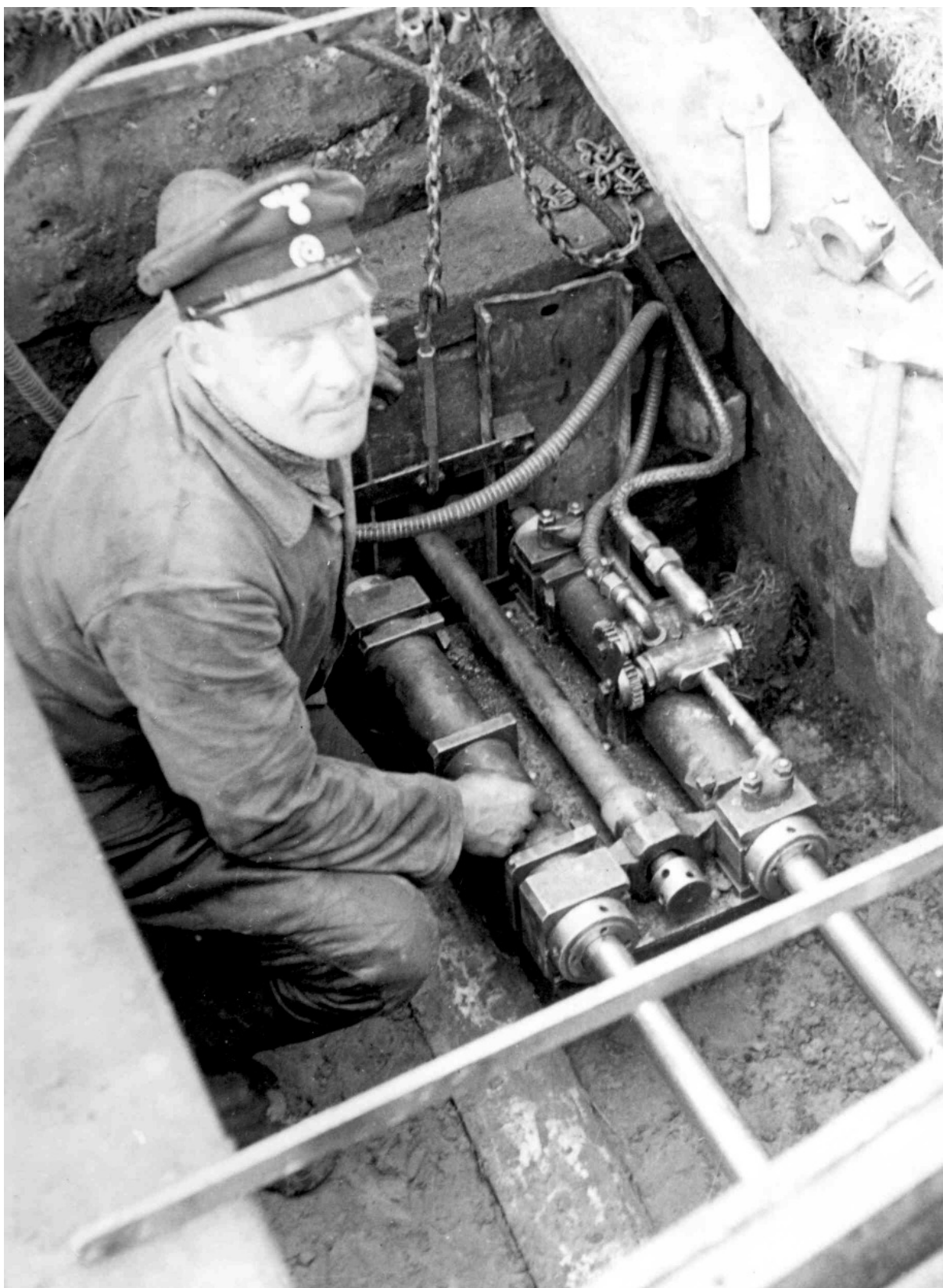
Einsatz des Stoßbohrgerätes. Foto: 1949.
