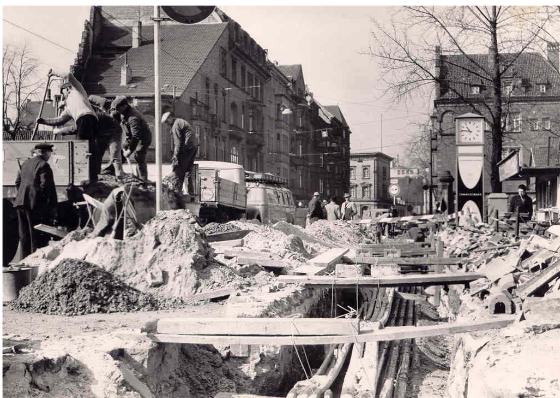
Umbau des Kabelkanals in der Friedrich-Ebert-Straße als Vorbereitung für den Bau des Fernmeldezentrams. Foto vom 14. November 1964.
