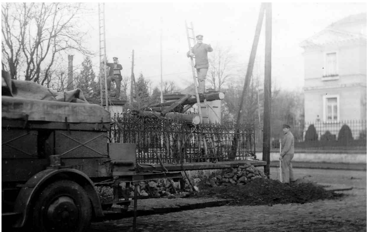
Bautrupp Halle in Rumänien.
