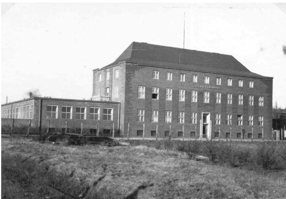
Das Hauptgebäude und der Südflügel nach der Fertigstellung 1930.
