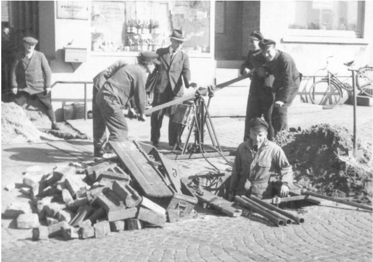
Einsatz des Stoßbohrgerätes. Foto: 1949. Von links, oberes Foto: Gerd Nabereit, Werner Zimmat, Husemann und Edmund Seidel.
