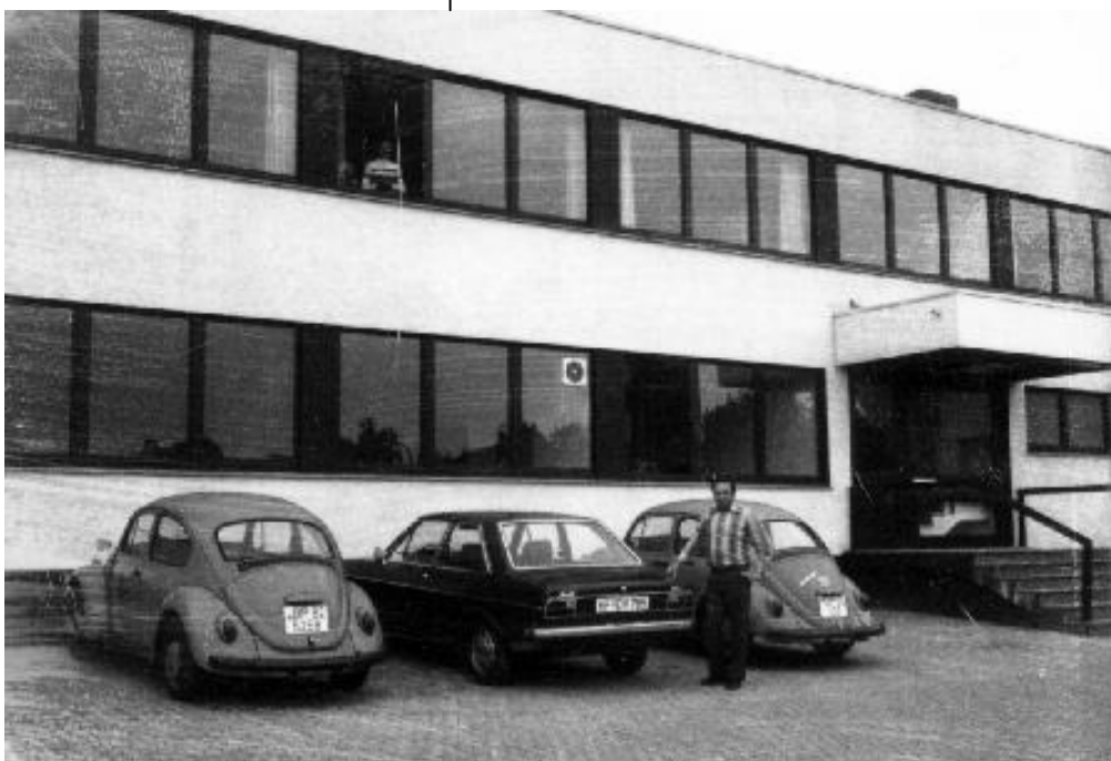
Vorderfront des neuen Gebäudes für den Fernmeldebaubezirk 21. Reiner Brückner (Disponent) „bewacht“ die Autos. Aus dem Fenster im ersten Stock beobachtet Antje Steiner (Geschäftszimmer) das Geschehen.
