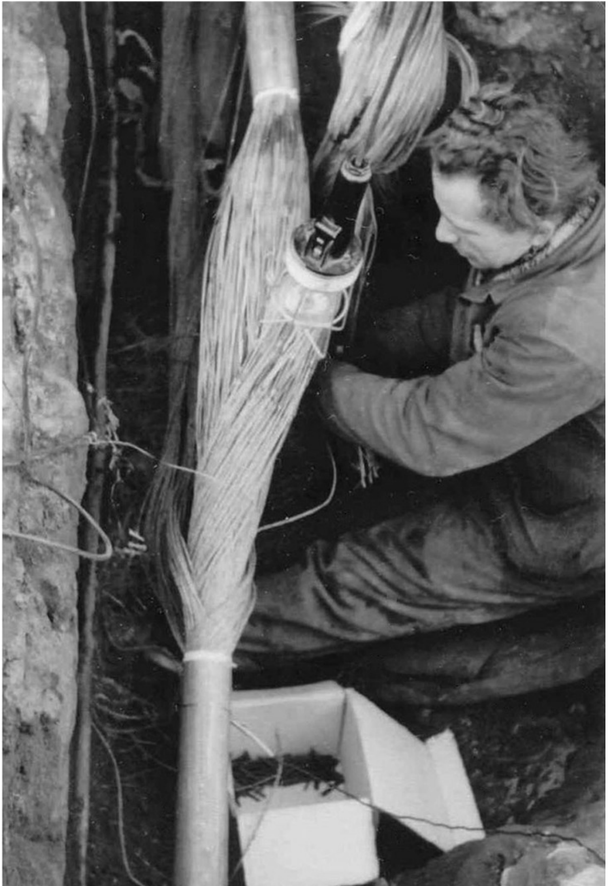
Spleissarbeiten an hochpaarigen Kabeln.
