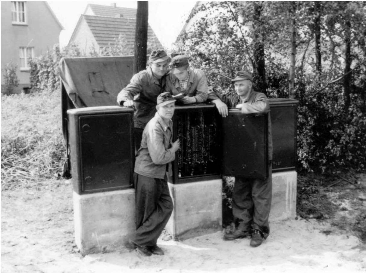
Bautrupp Halle 1954. Am Kabelverzweiger und Wählsternschalter in Tatenhausen. Vorne: Herbert Lorenz (links), Leo Thiede. Hinten: Willibald Richter (links), Werner Wittkamp.
