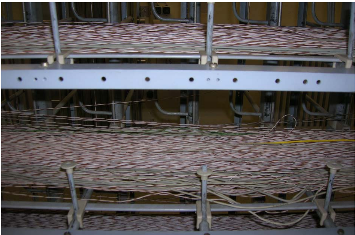
Aufnahme vom 06. Juli 2006 am Hauptverteiler Bielefeld 6-Mitte. Oben: Kabel auf dem Kabelrost über dem Hauptverteiler (verbinden den Hauptverteiler mit den Rufnummern und anderen techn. Einrichtungen). Unten: Schaltdrähte auf der waagerechten Seite des Hauptverteilers (verbinden die waagerechte, die Kabelseite, mit der senkrechten, der Rufnummernseite).
