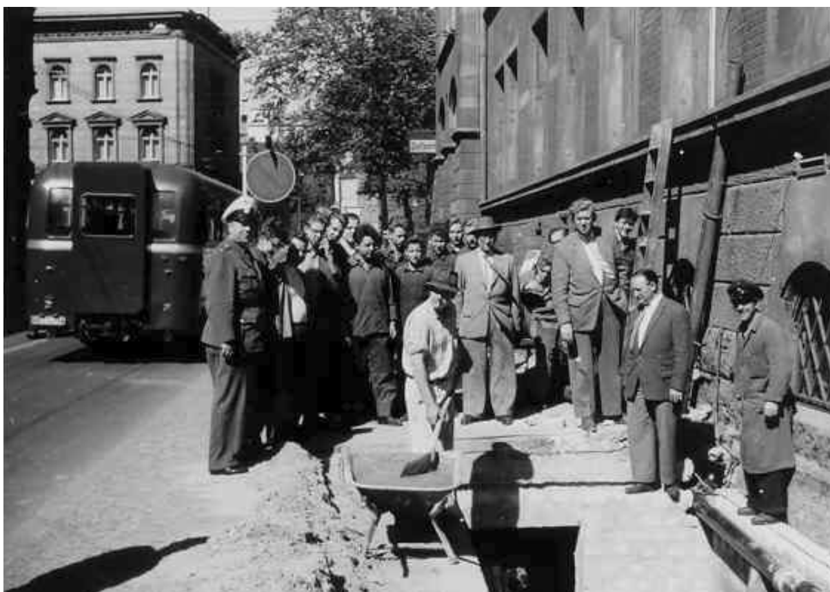
Einbau eines Kabeleinführungsschachtes am Postamt in der Friedrich-Ebert-Str. in Bielefeld. Von rechts: Erich Berner, Waldemar Dzulko (Bautruppführer), Ewald Kobusch (Bezirksbauführer). Foto von 1968.
