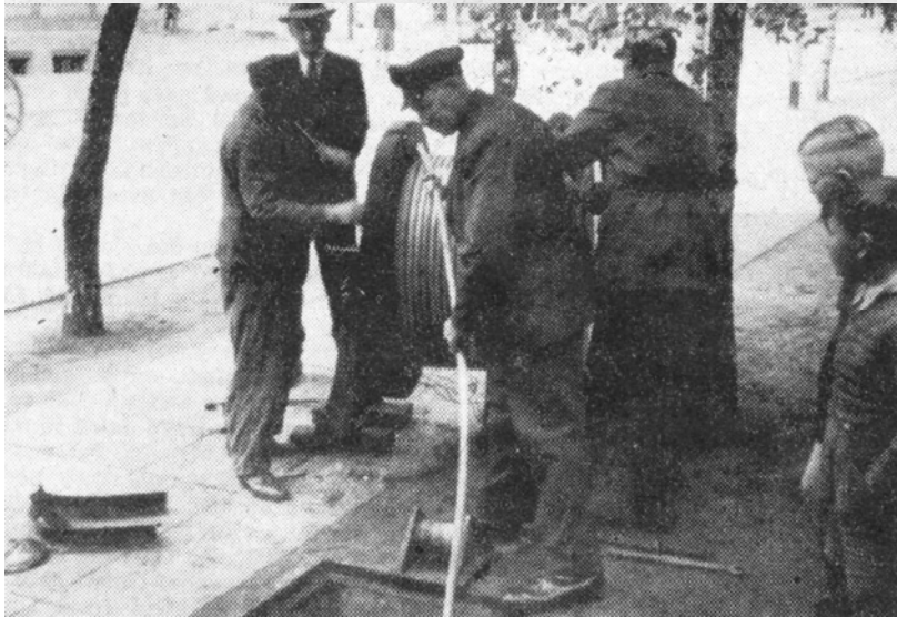
Im Bürgersteig der Bahnhofstraße liegt ein Kanal eigens für Fernsprechkabel, dem gestern ein weiteres hinzugefügt wurde. Aufnahmen: FP (Bölling)
