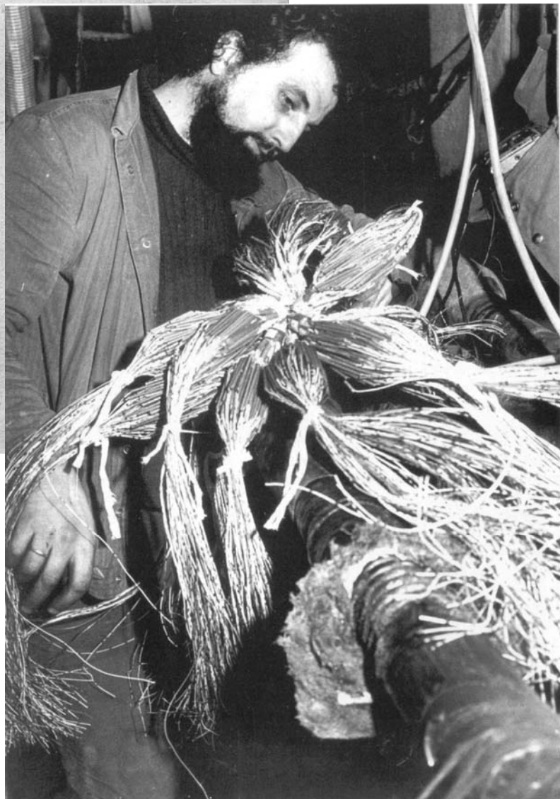
Kein leichtes Arbeiten für den Fernmeldetechniker R. Mader An der Egge: Im zwei Meter tiefen und sehr engen Bauloch muß er 1500paarige Leitungen aus dem Kabel nehmen und erneuern. Foto: Ed. Heidmann
