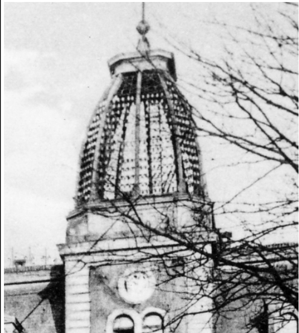
Abspannturm für Freileitungen auf dem Kaiserlichen Postamt an der Bahnhofstr. Ecke Jahnplatz.
