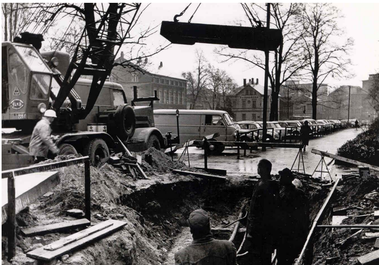
Einbau eines Kabelschachtes in Bielefeld. Foto 1962, Stadtarchiv.
