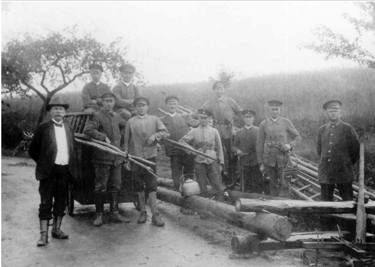
Bei der Gründung des Telegrafenaufbauamtes 1920 gab es als einziges „Fahrzeug“ den Schubkarren. Auch die Bielefelder Bautrupps waren damit ausgerüstet. Das Foto zeigt den Telegrafenaufbautrupps Lübbecke mit seinem Bautruppführer Maschmann, ganz rechts, daneben der Vormann und spätere Bautruppführer des Lübbecker Bautrupps Niemeier. Ganz links der Hilfsaufbauführer Kluge, anlässlich dessen Ausscheiden aus dem Dienst im Jahre 1920 diese Aufnahme gemacht wurde.
