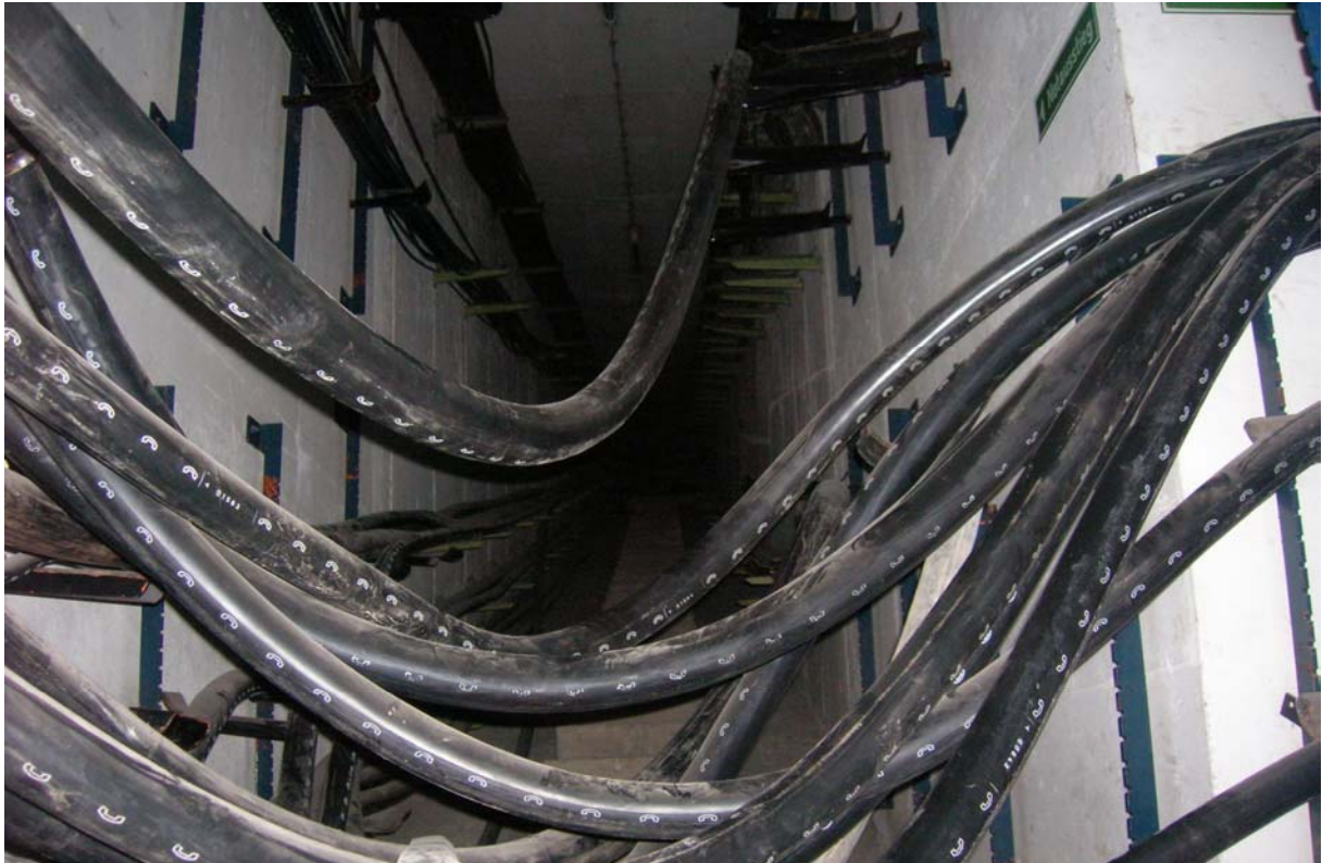
Aufnahme vom 06. Juli 2006 im Kabelaufteilungskeller Bielefeld Mitte. Kabelzuführung vom Einführungsschacht in den Kabelaufteilungskeller.
