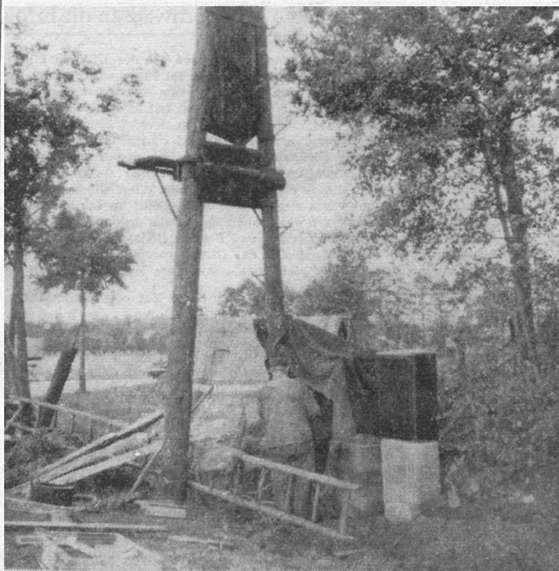
Auf dem FP-Bild am Mast: Der alte Kabelverzweiger, auf dem bisher das vom Fernsprechamt kommende 75paarige Kabel endete. Das Blechgehäuse in der Mitte ist der neue Kabelverzweiger, der auf beiden Seiten von Wahlsternschaltern flankiert ist.
