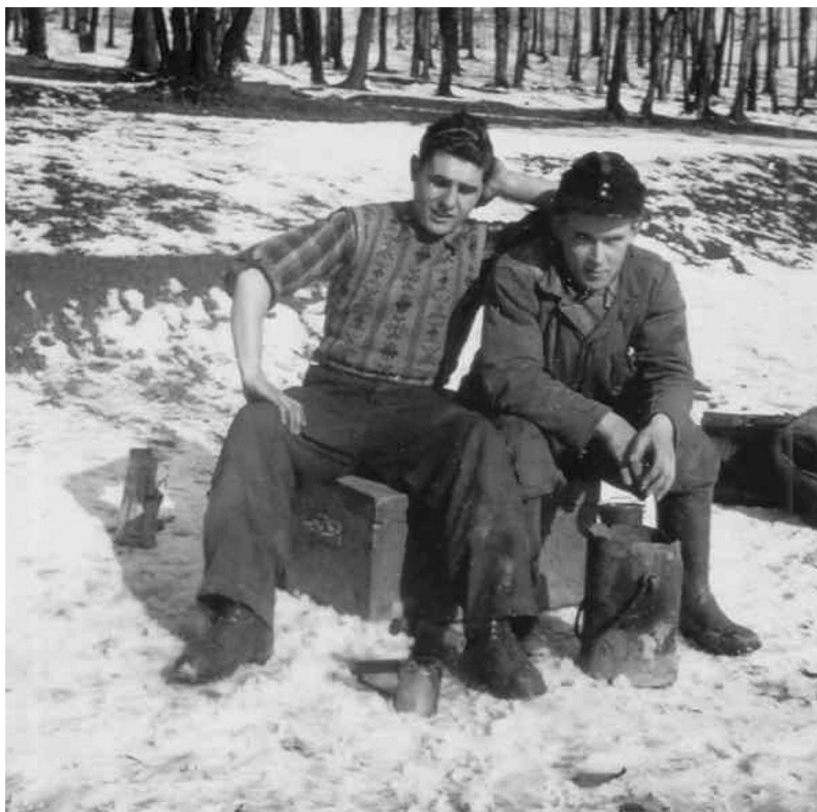
Kabellöter des Bautrupps Kleine-Benne im Februar/ März 1952 in Olderdissen. Harald Ullrich (links) und Joachim Nimpesch.
