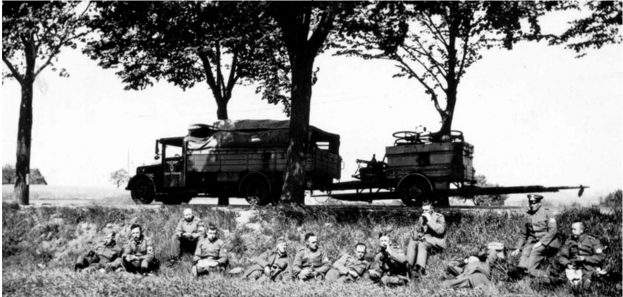
Bautrupp Halle. Auf der Fahrt von Köln über Gmünd nach Monschau/Eifel am Sonnabend 18. Mai 1940.
