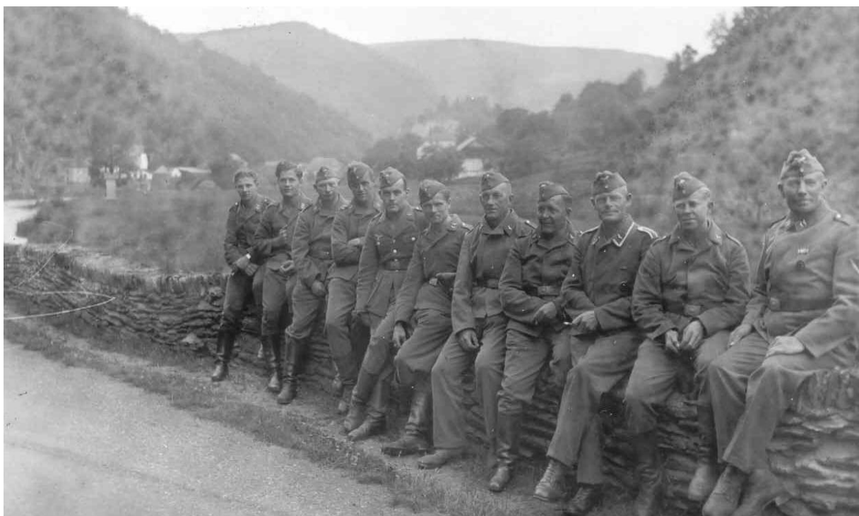
Bautrup Halle in Luxemburg, Stolzenburg an der Tauer. Von rechts: 1. Vorarbeiter August Lohmann, 5. Gustav Goth, 7. Bentlage.
