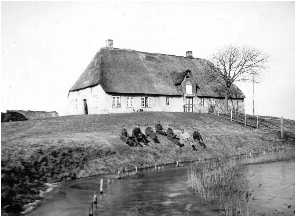
Bautrupp Halle auf der Hallig Nordstrand.
