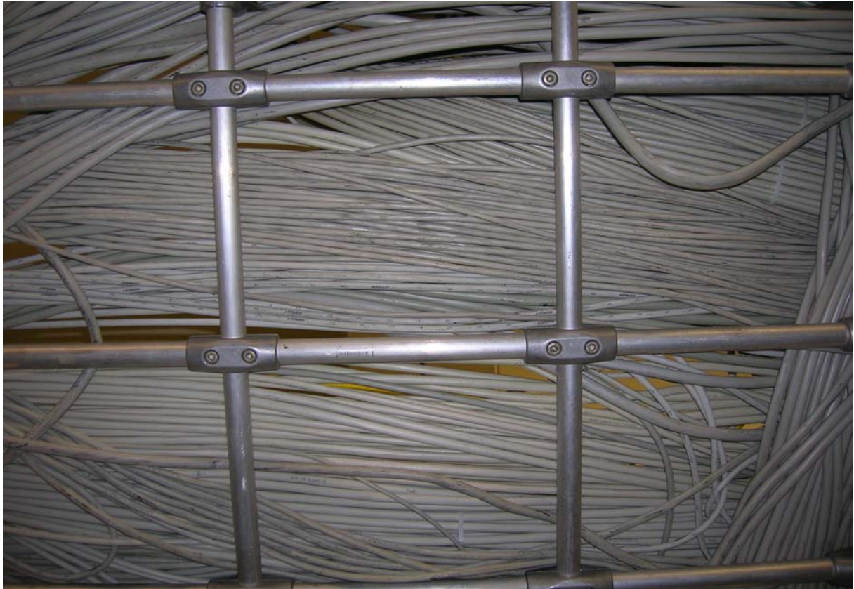
Aufnahme vom 06. Juli 2006 am Hauptverteiler Bielefeld 6-Mitte. Oben: Kabel auf dem Kabelrost über dem Hauptverteiler (verbinden den Hauptverteiler mit den Rufnummern und anderen techn. Einrichtungen). Unten: Schaltdrähte auf der waagerechten Seite des Hauptverteilers (verbinden die waagerechte, die Kabelseite, mit der senkrechten, der Rufnummernseite).
