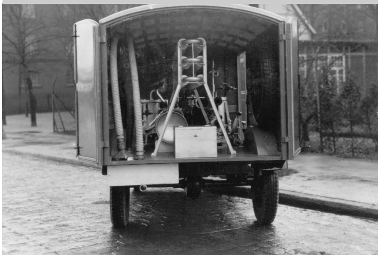
1954 erhielt das Fernmeldebauamt Bielefeld ein neues, modernes, mobiles Druckluftprüfgerät, das je nach Bedarf bei den Baubezirken zum Einsatz kam.
