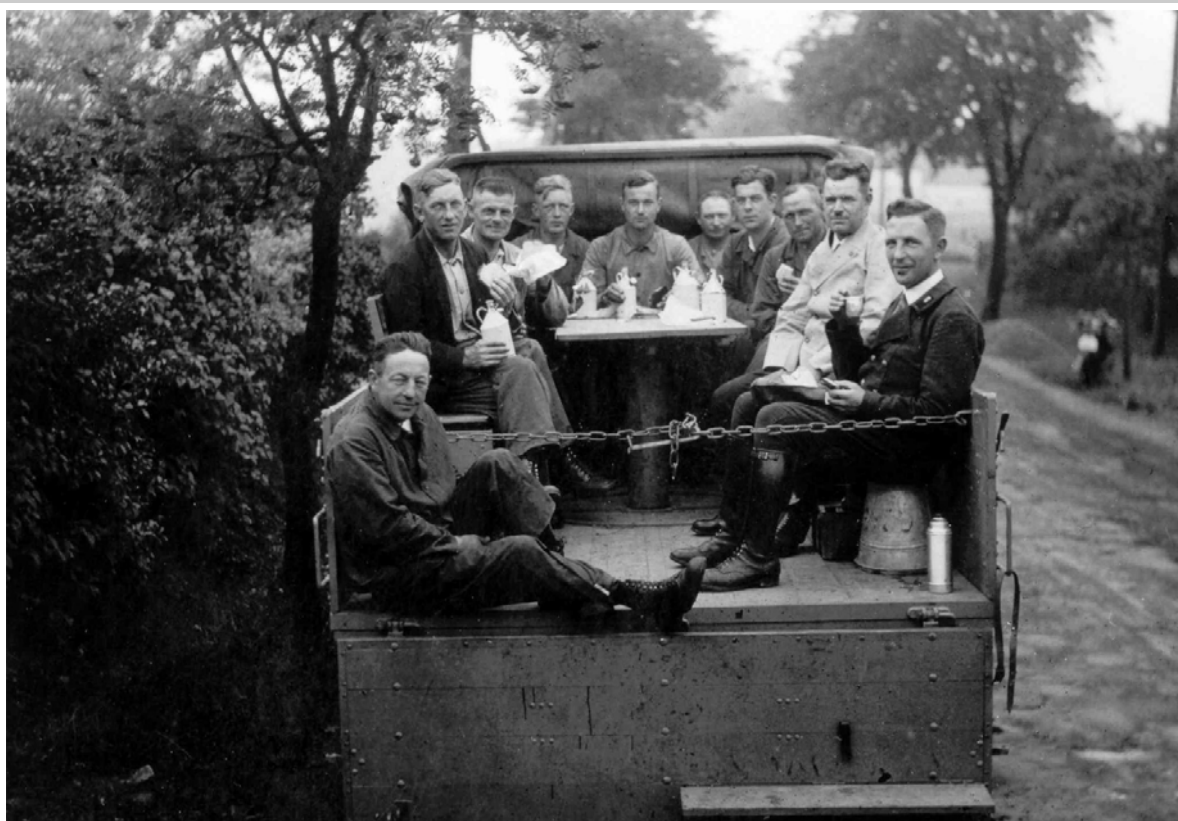
Bautrupp Halle. Oben in der Mitte Fahrer Kölling. Von links: 5. Hermann Heitmann, links davon Vorarbeiter August Lohmann.
