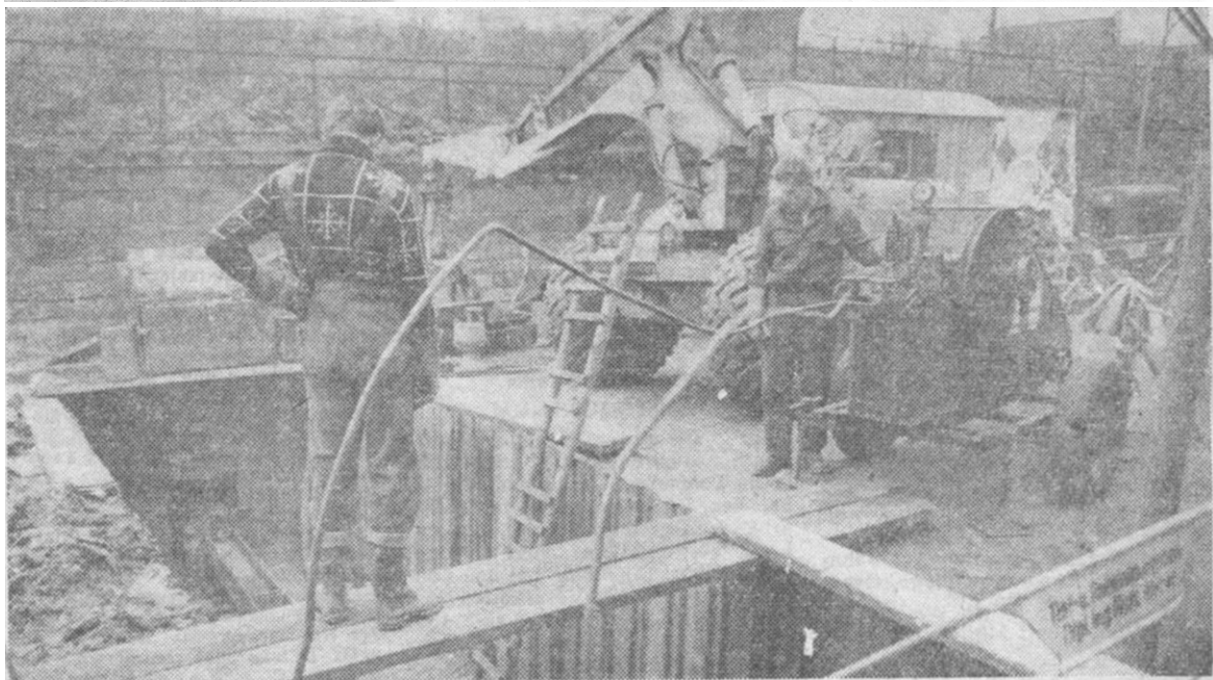
Vor dem Werkstor der Kochs Adlerwerke wurde in diesen Tagen eine Baugrube ausgehoben, von der aus der Bahndamm mit einem 70 Zentimeter starken Stahlrohr durchbohrt werden soll.
