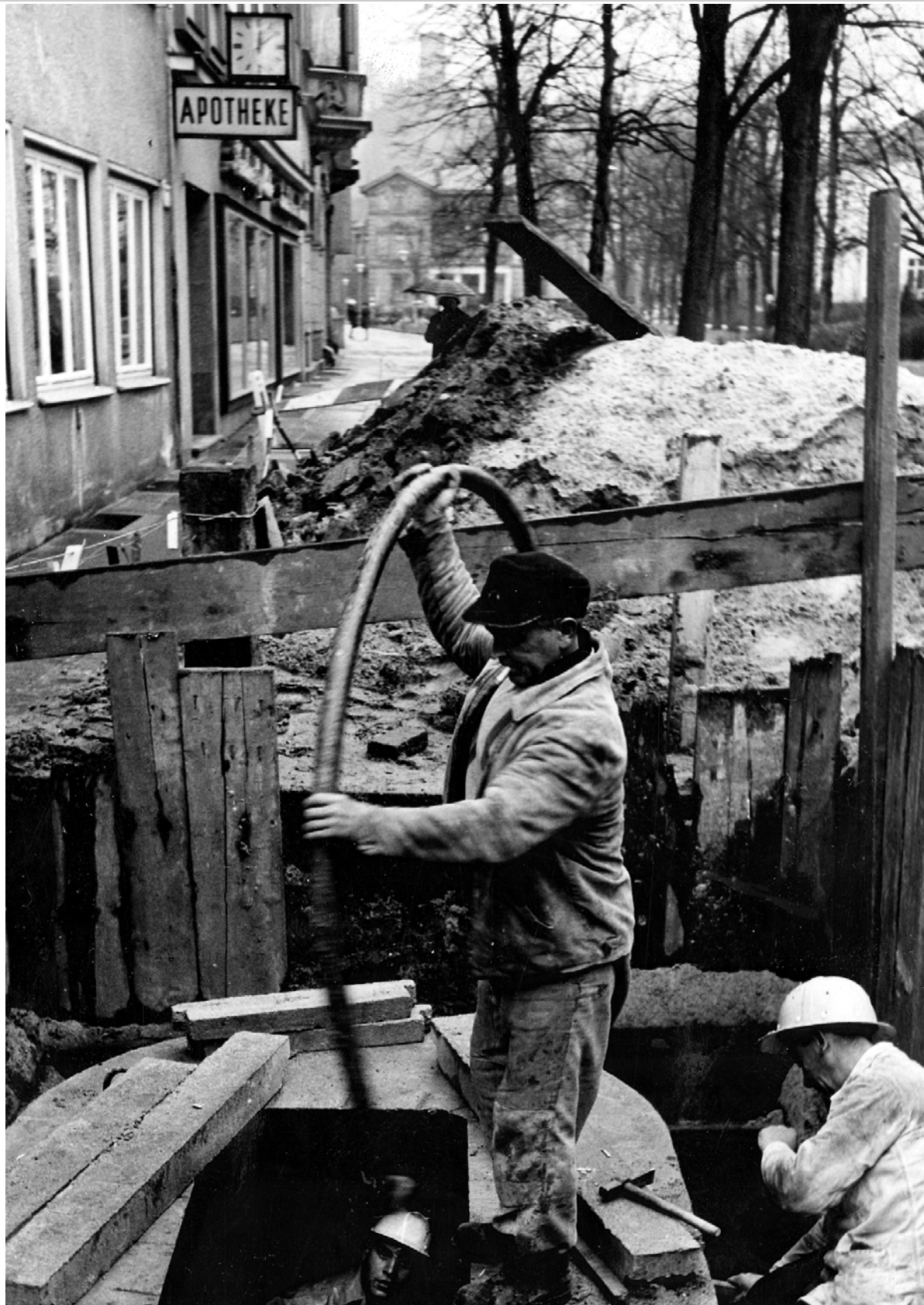
Kabel einziehen in einen neu gebauten Kabelschacht, Alfred-Bozi-Str. zwischen Klosterstraße und Waldhof/Obernstraße mit Blick auf die Sparrenburg. Hinten ganz rechts auf dem Foto ist die Handwerkskammer zu sehen. Foto: Heidmann 1962.
