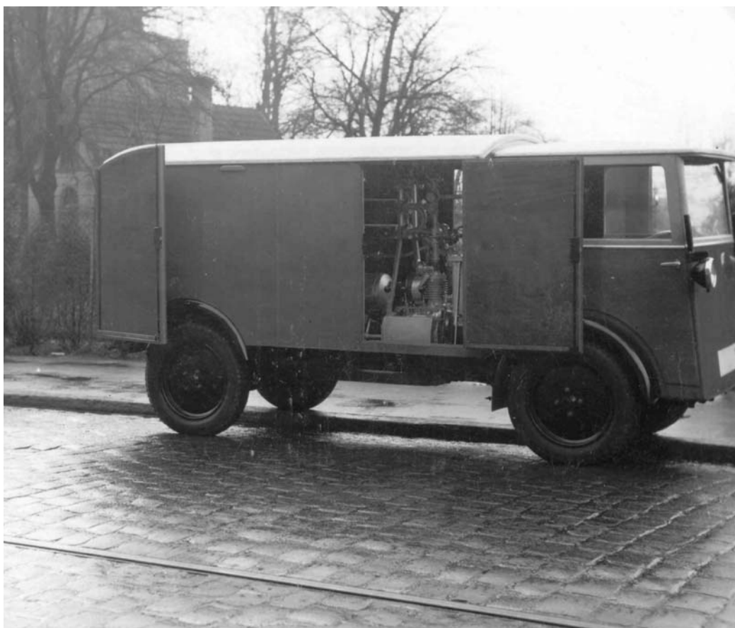
1954 erhielt das Fernmeldebauamt Bielefeld ein neues, modernes, mobiles Druckluftprüfgerät, das je nach Bedarf bei den Baubezirken zum Einsatz kam.
