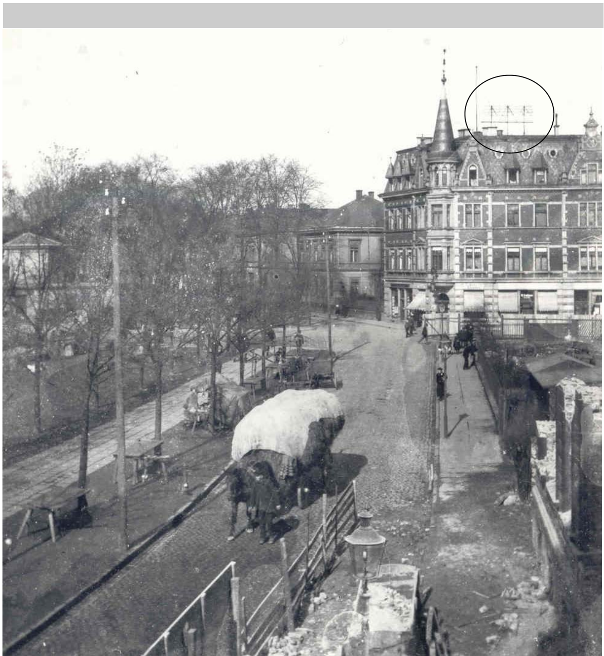
Niederwall 11 im März 1902. Blick Richtung Norden.
