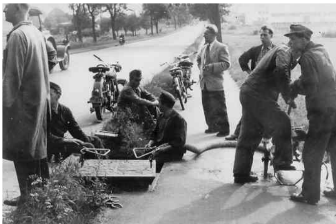
Fernkabelbautrupps des Fernmeldebauamtes Bielefeld am Kabelkanal des „Rheinlandkabels“ an der Bundesstraße 61 zwischen Bielefeld und Gütersloh, etwa 1952/1953. Da die Anlage nicht, wie noch bis zu Anfang des 2. Weltkrieges, regelmäßig gewartet wurde, waren die Dränaugen verstopft und nach dem Öffnen des Schachtes musste erst das Wasser herausgepumpt werden.
