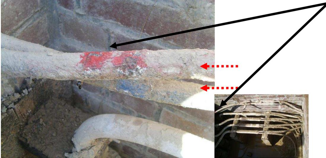
Abbildung 33: die TF Kabel ◀■■■ nach Bielefeld waren mit den Farben rot und blau markiert
