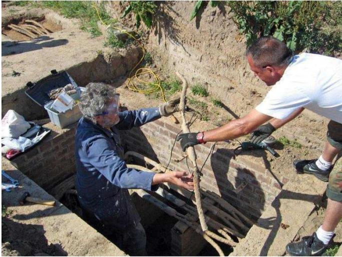
Abbildung 4: Ausbau eines TF-Kabels
