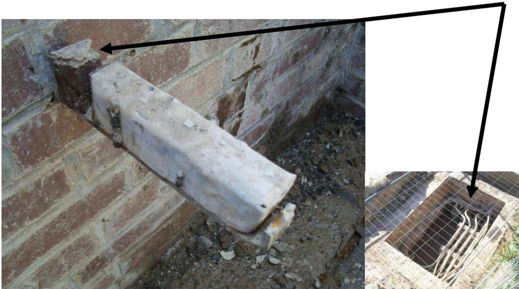
Abbildung 29: Kabelhalter mit Holzstück und Bleiumhüllung oberhalb der Pupinspulen
