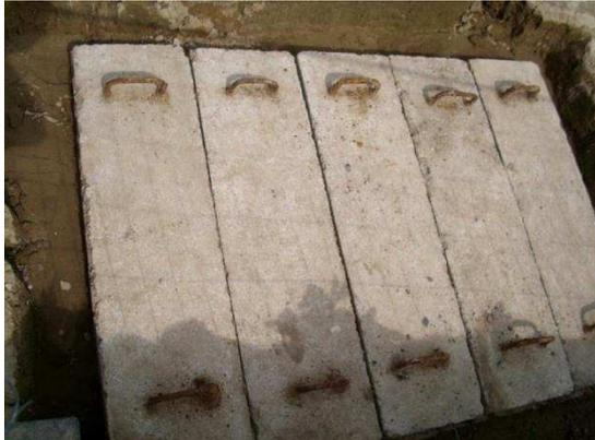
Abbildung 1: Schachtdeckel des Kabelschachts Im Römerlager
