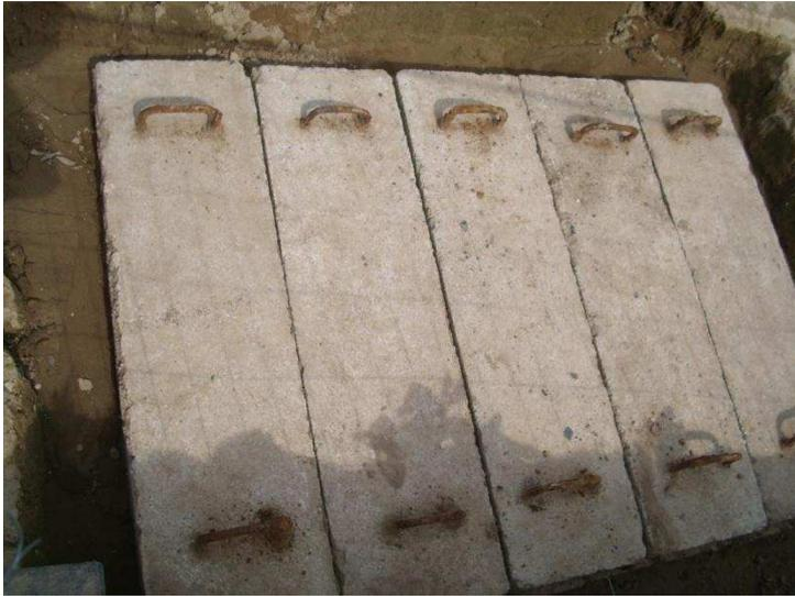
Abbildung 10: Abdeckung des Kabelschachts
