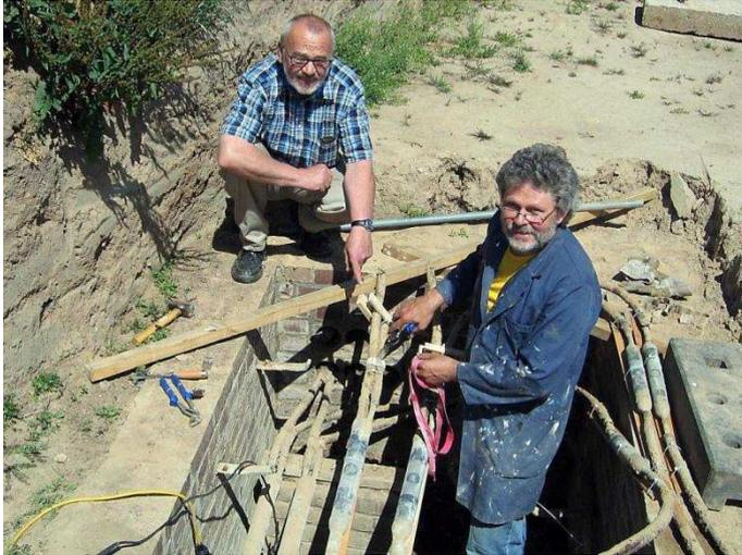
Abbildung 6: das dritte NF-Kabel ist teilweise angehoben
