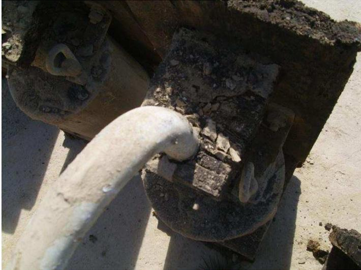
Abbildung 44: Anschlußkabel mit hölzernem Kabelhalter
