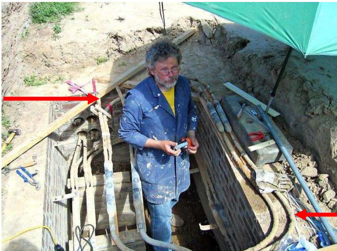
Abbildung 5: zwei NF Kabel wurden angehoben und auf der Mauer abgelegt ←
