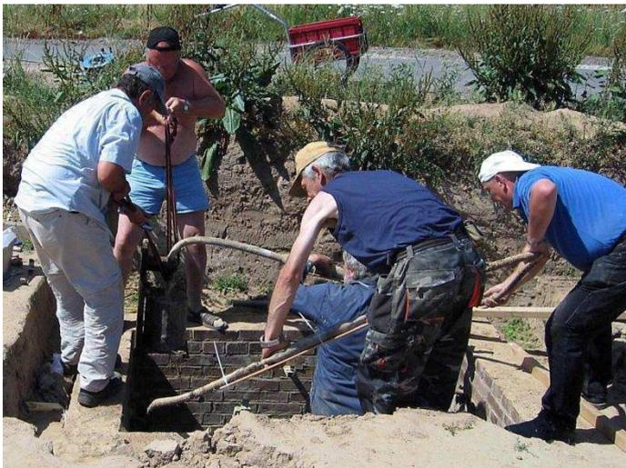
Abbildung 7: eine Pupinspulenmuffe mit den dazugehörigen Kabeln und Muffen wird geborgen
