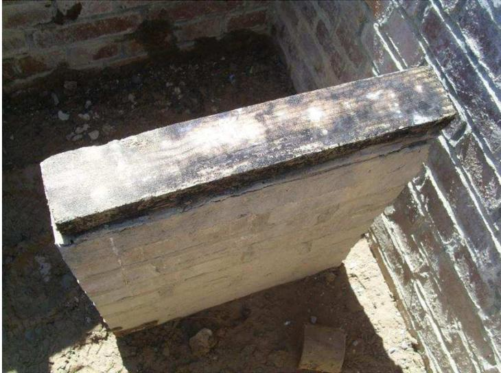
Abbildung 25: Kantholz nach Entfernung des Bleikastens
