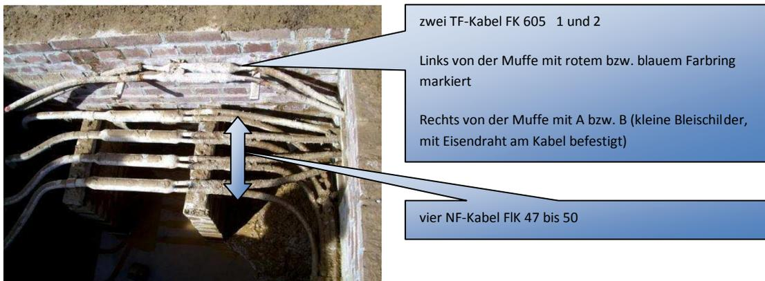
Abbildung 2: unten die 4 Kabel FIK 47 - 50, die mit den Pupinspulen (links) verbunden sind
