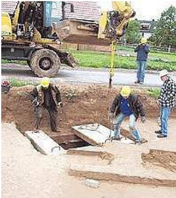
Nur mit einem Bagger konnten die schweren Betonplatten angehoben werden. | Foto: privat
