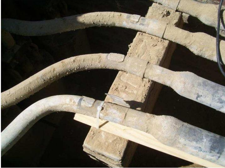
Abbildung 37: Muffen mit Anschlußkabel der Pupinspule nmuffen
