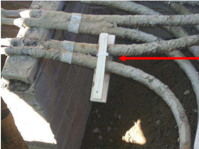
Abbildung 2: Stabilisierung parallel verlaufender Kabel
