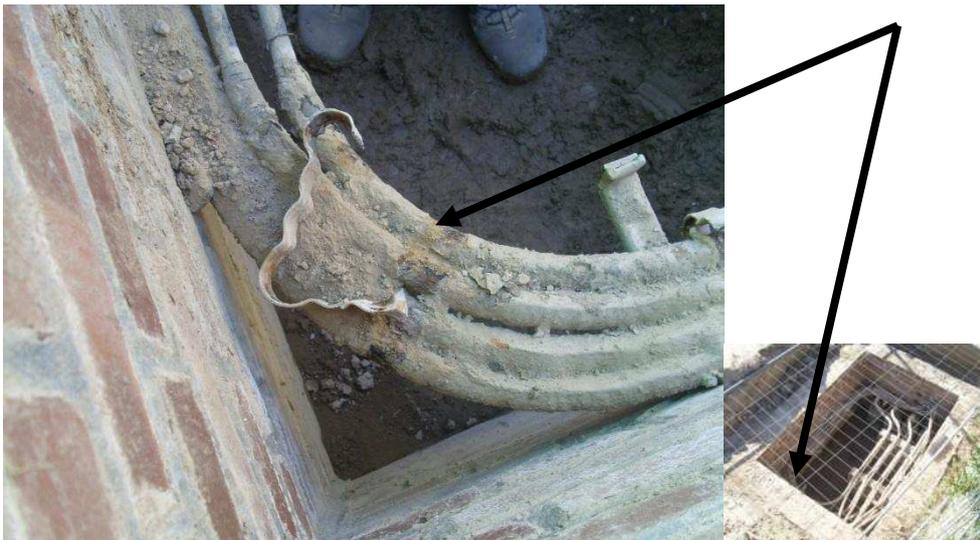
Abbildung 32: NF-Kabel Richtung Bad Oeynhausn mit durchtrennten Bleibändern
