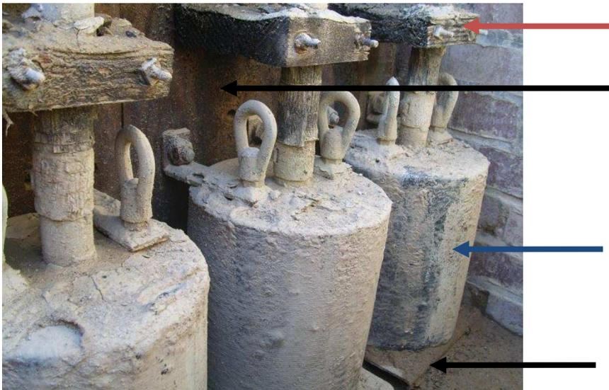
Abbildung 40: Pupinspulenmuffen ← auf Holzbrettern montiert ←
