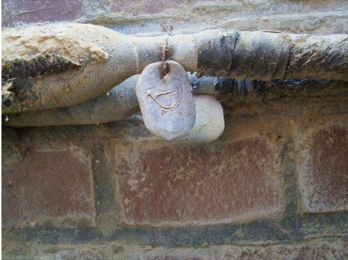
Abbildung 35: zwei der vier NF-Kabel Richtung Bad Oeynhausen mit „D“ bzw. „DD“ gekennzeichnet
