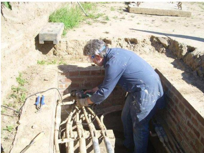
Abbildung 3: Durchtrennung der TF-Kabel (TF =Trägerfrequenz)
