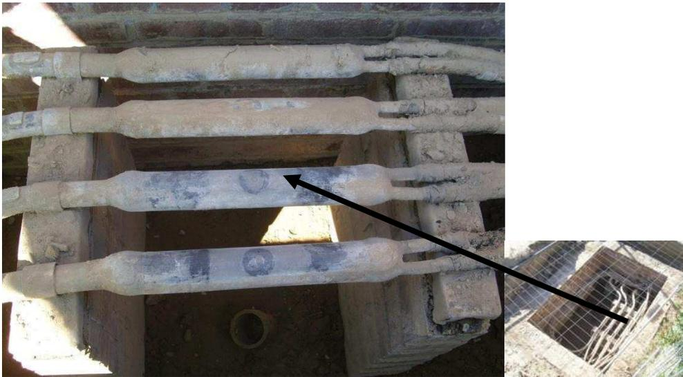
Abbildung 38: Muffen mit Anschlußkabel der Pupinspule nmuffen (links) und NF-Kabeln
