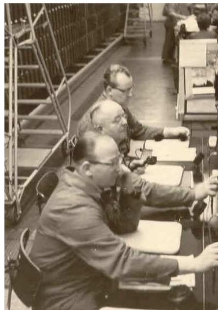
**Im 1. Stock des Postamtes standen die Prüf-schränke direkt neben dem Hauptverteiler**
