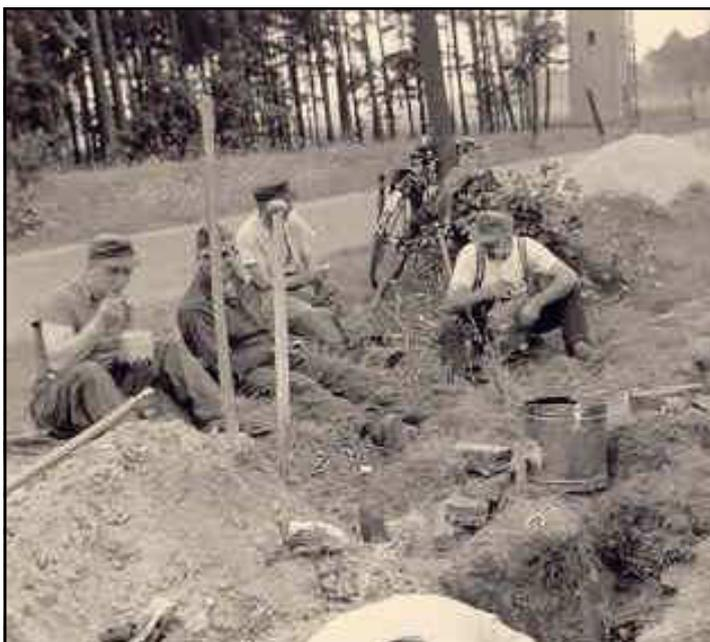
Mittagspause. In dem Blecheimer befand sich eine Bitumenmasse. Mit ihr wurden die Lötstellen „vergossen“, um sie vor Korrosion und mechanischen Schäden zu schützen
