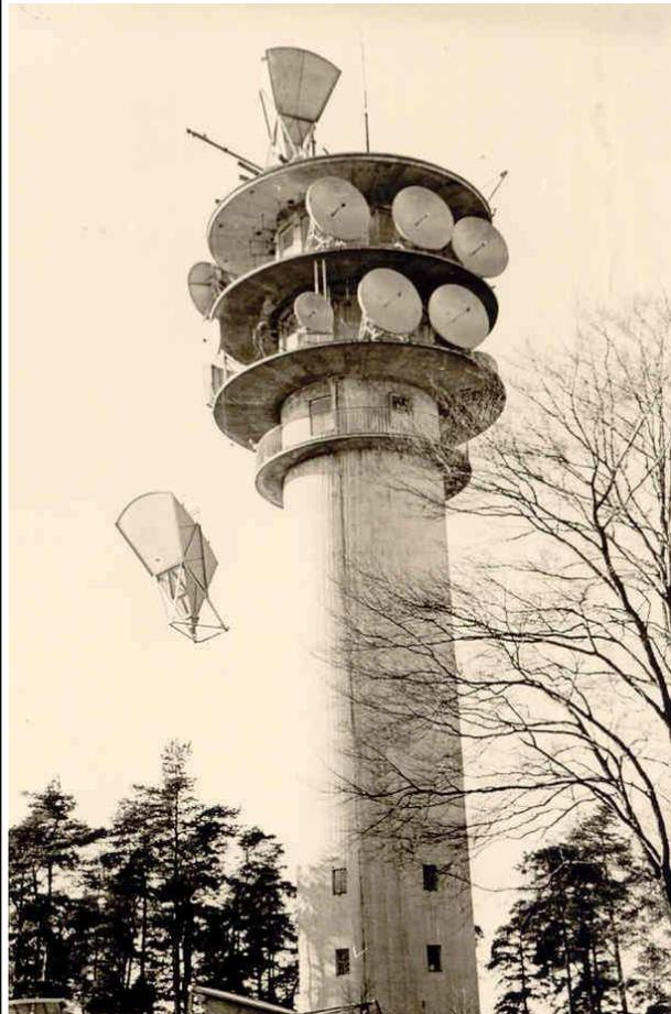
Januar 1958. Die erste 4 Gigahertz-Hornparabol-Antenne wird auf der Hünenburg installiert.
