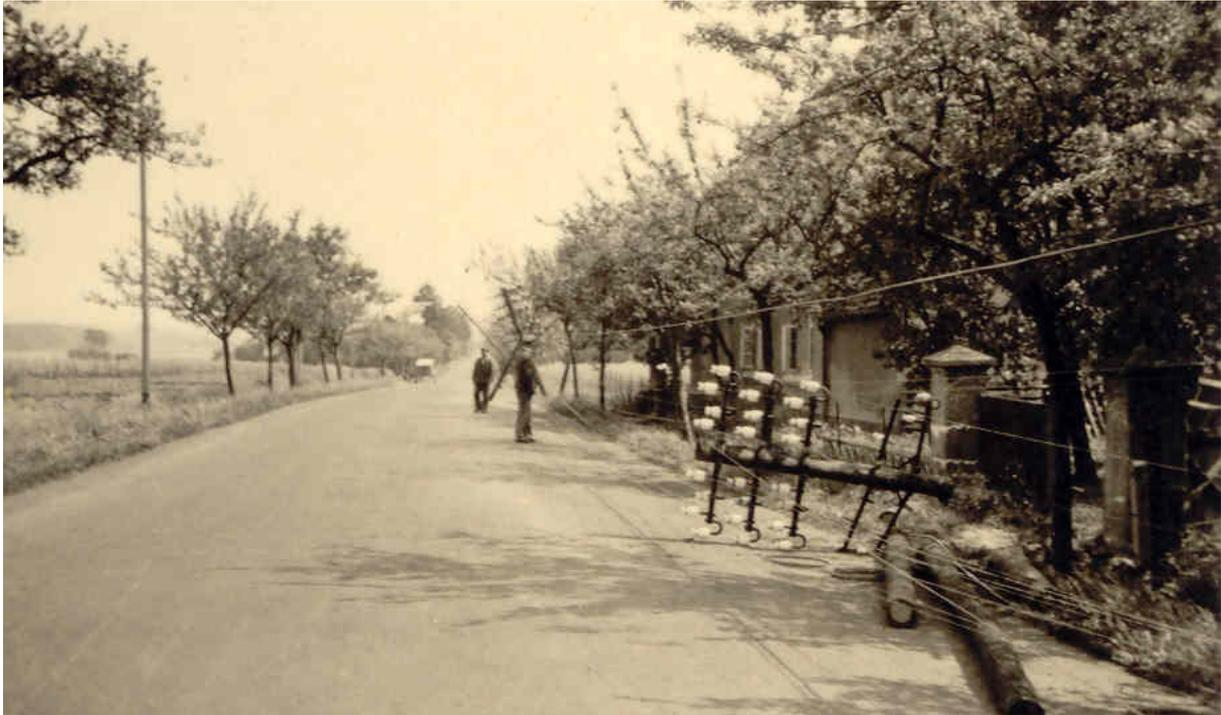
Im Kabelmessdienst zwischen Lage und Detmold 1934. Umgestürzte Freileitungsmasten mit fünf Querträgern.
