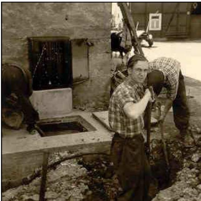
„Schanzen“. Bis zum Ende der 50er Jahre gehörten Hacke, Spaten und Schaufel mit zur Grundausrüstung der Kabellöter. Die Lötgruben und manchen Meter Kabelgraben mussten sie ausschachten und wieder verfüllen.
