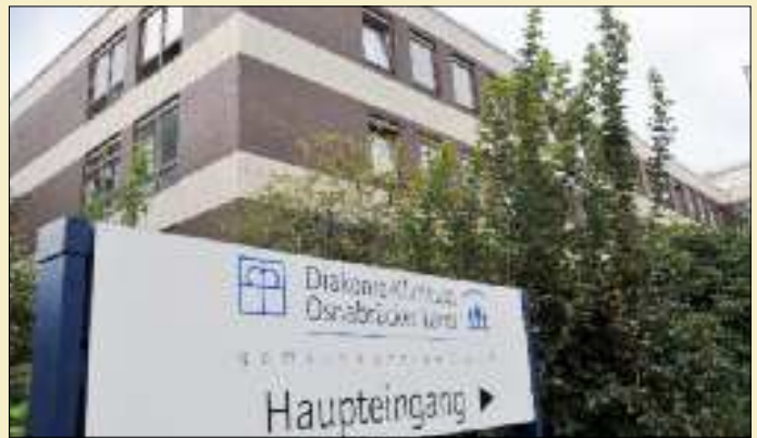
Sanierungs- und modernisierungsbedürftig: Das Diakonie-Klinikum Osnabrücker Land in Dissen.
