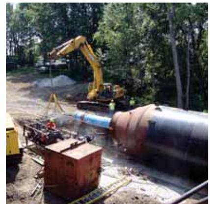
Rohrvortrieb mit der TT-Rammtechnik
