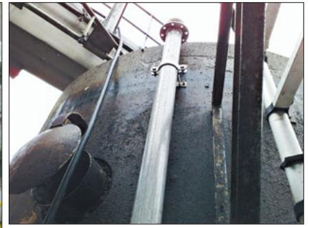
Neu entwickelte und eingebaute Becken-Entleerungsleitung aus Edelstahl.
