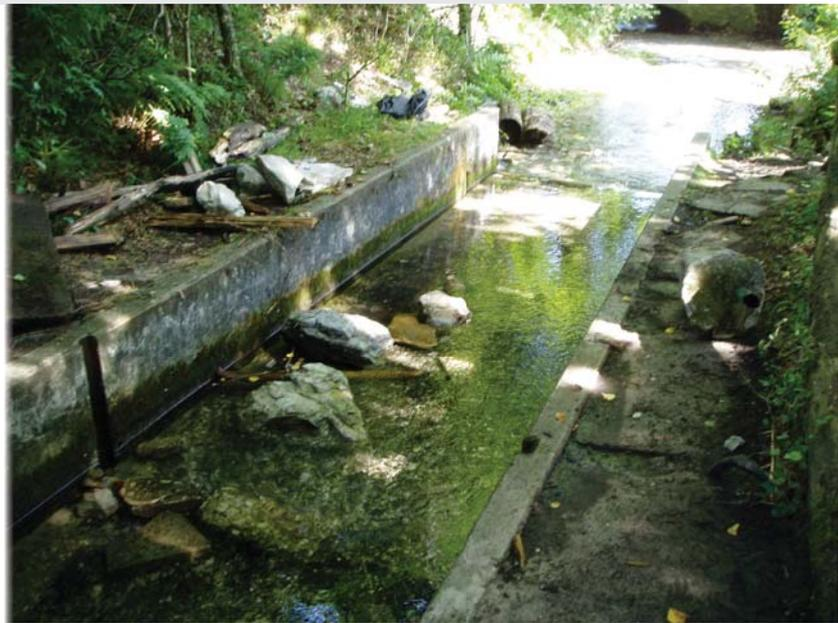
Bild 2: Steine im Messprofil des Pegels Pivitsheide/ Rethlagerbach
