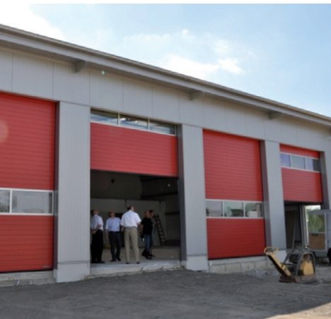
Neubau Feuerwehrgerätehaus Aminghausen-Päpinghausen
