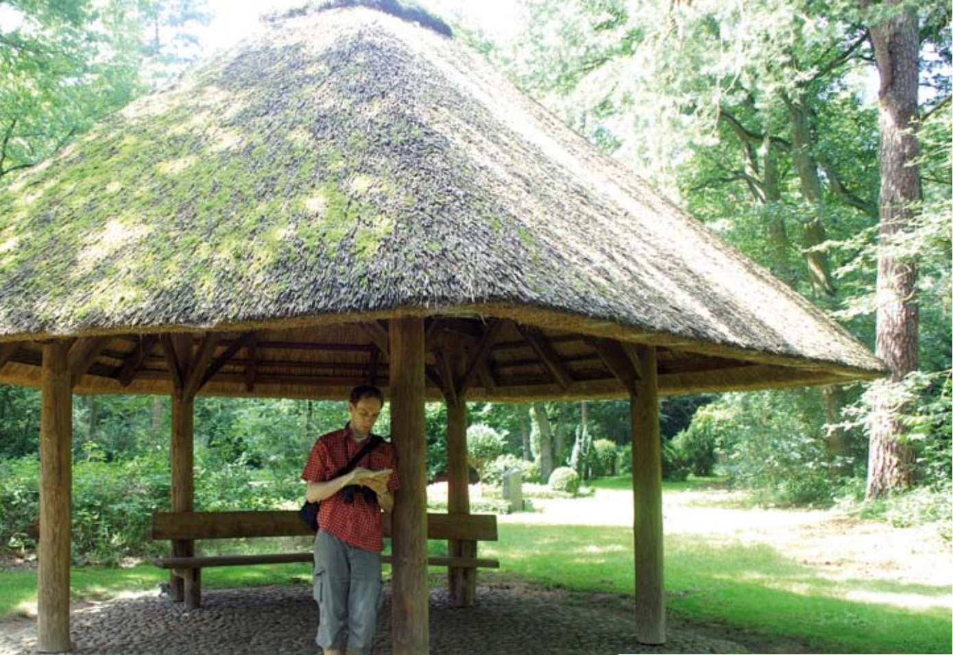
Reetdächer bieten an verschiedenen Stellen auf dem Waldfriedhof Schutz vor feuchten Überraschungen.
