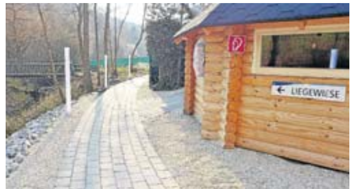
Die Pflaster- und die Beleuchtungsarbeiten im Außenbereich der Sauna wurden bereits abgeschlossen.
