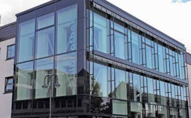
Neue Bibliothek im Bau
